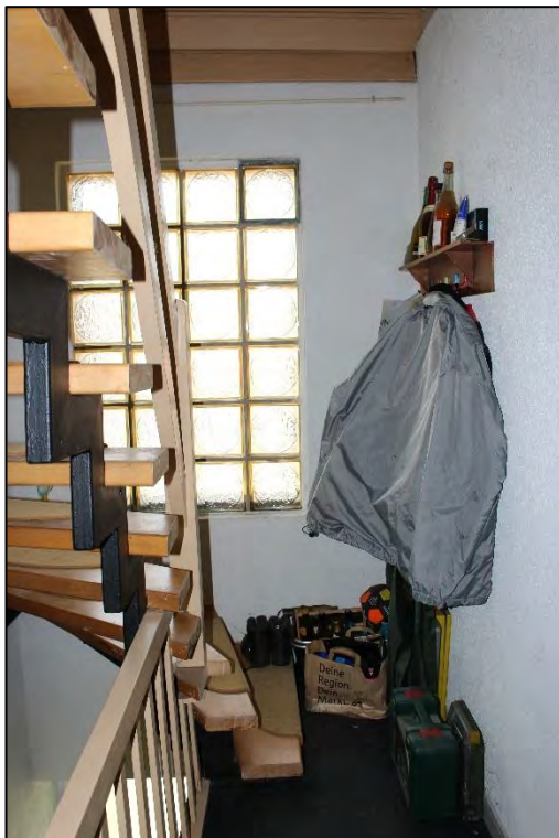
Foto Nr. 52: Treppe zum Dachgeschoss
