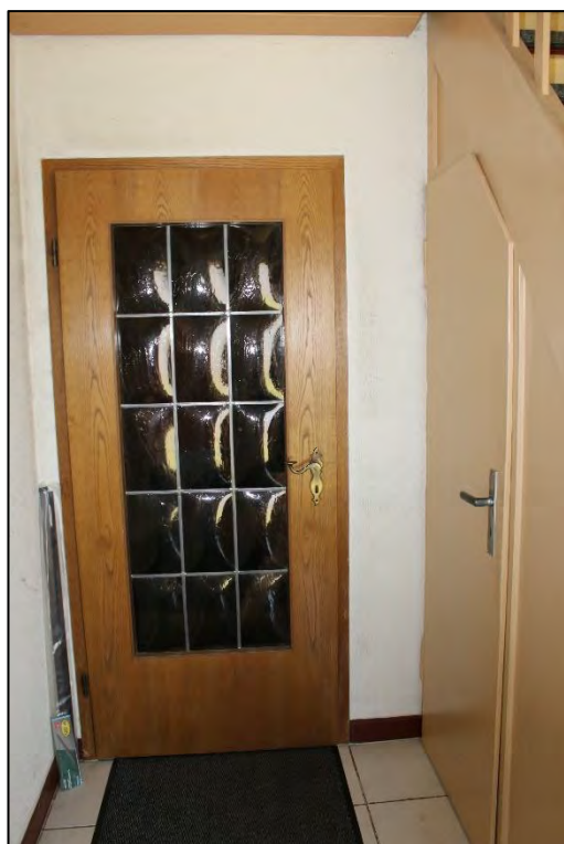
Foto Nr. 40: Erdgeschoss, Gemeinschaftstreppenhaus, Eingang WE Nr. 1
