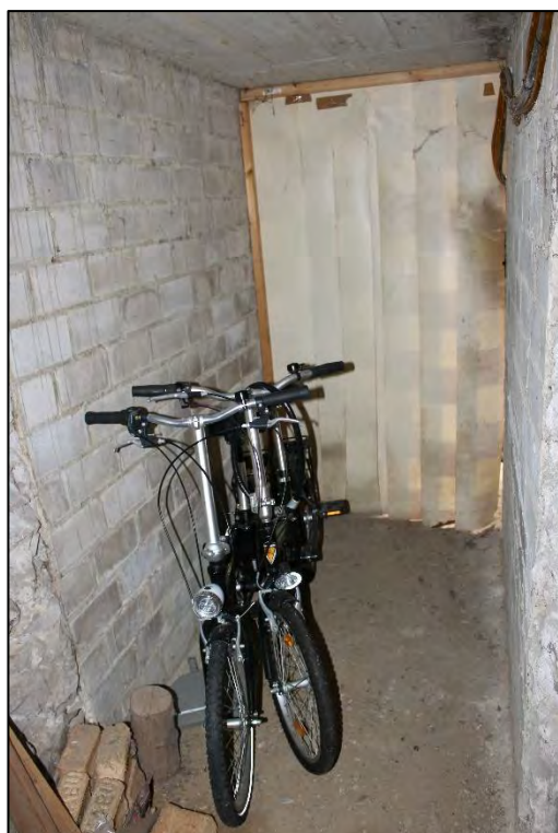
Foto Nr. 36: Kellergeschoss, Flur
