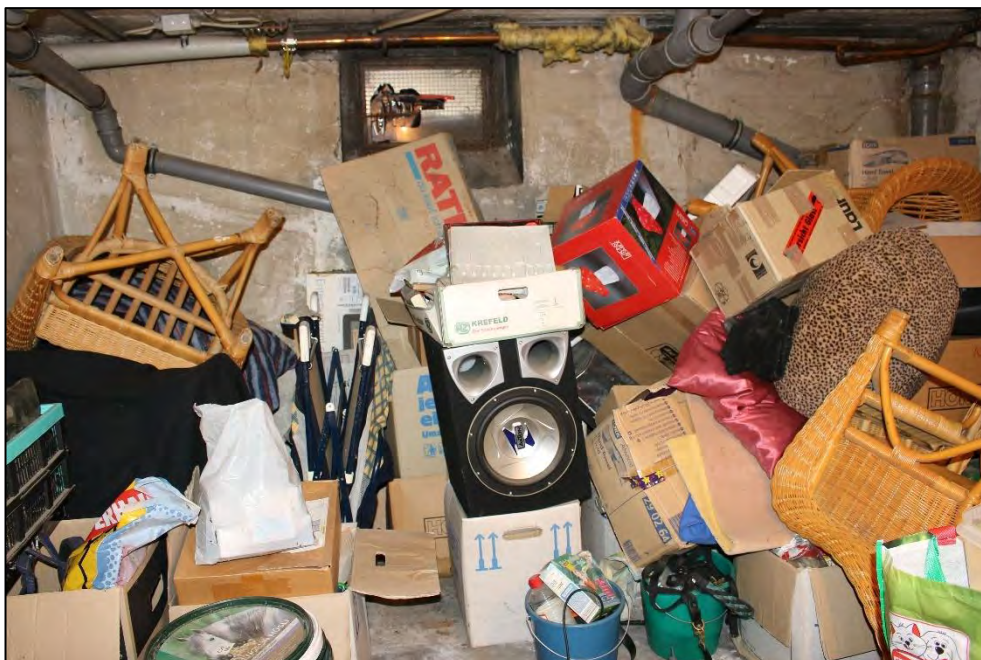
Foto Nr. 34: Kellergeschoss, Kellerraum
