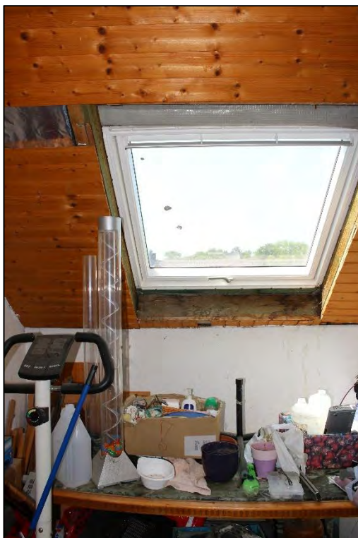
Foto Nr. 62: Dachgeschoss, Raum 2
