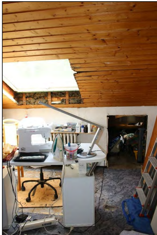
Foto Nr. 63: Dachgeschoss, Raum 3
