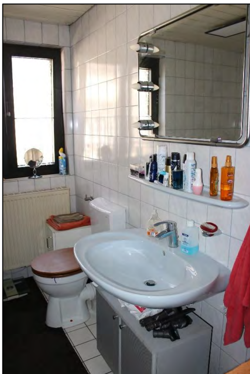
Foto Nr. 44: Erdgeschoss, WE Nr. 1, Bad
