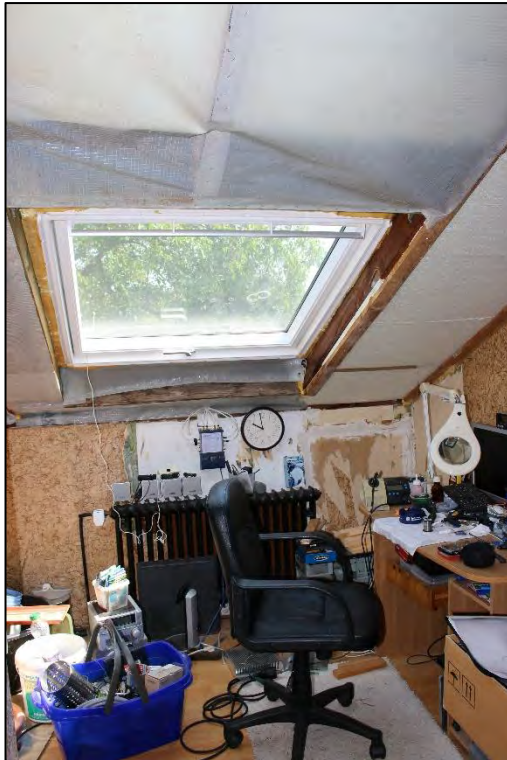
Foto Nr. 61: Dachgeschoss, Raum 2
