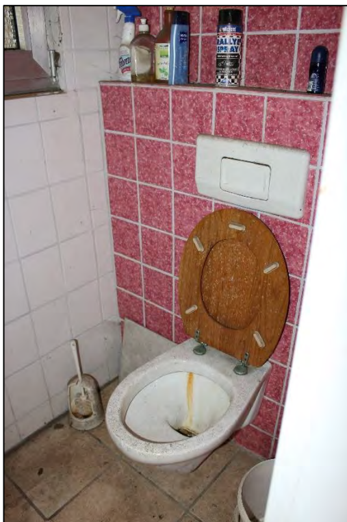
Foto Nr. 14: Nebengebäude, WC
