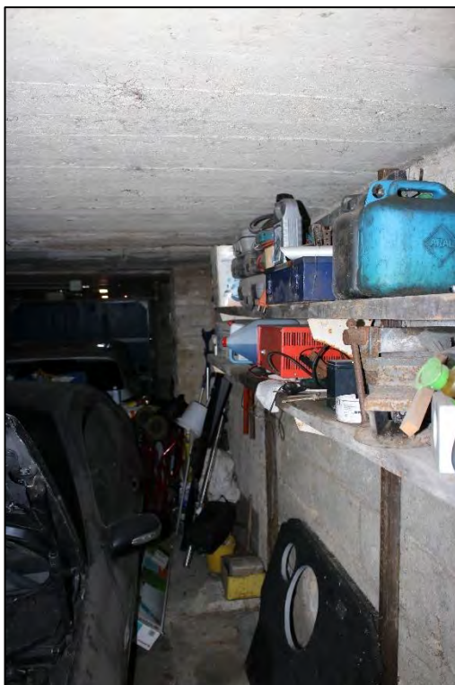
Foto Nr. 22: Garage innen
