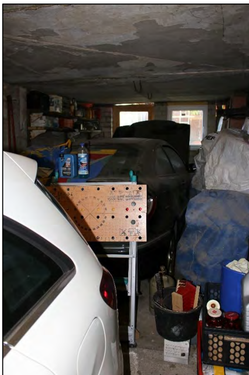
Foto Nr. 24: Garage innen
