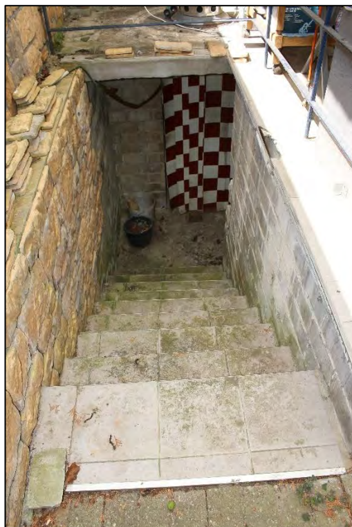
Foto Nr. 26: Kelleraußeneingang
