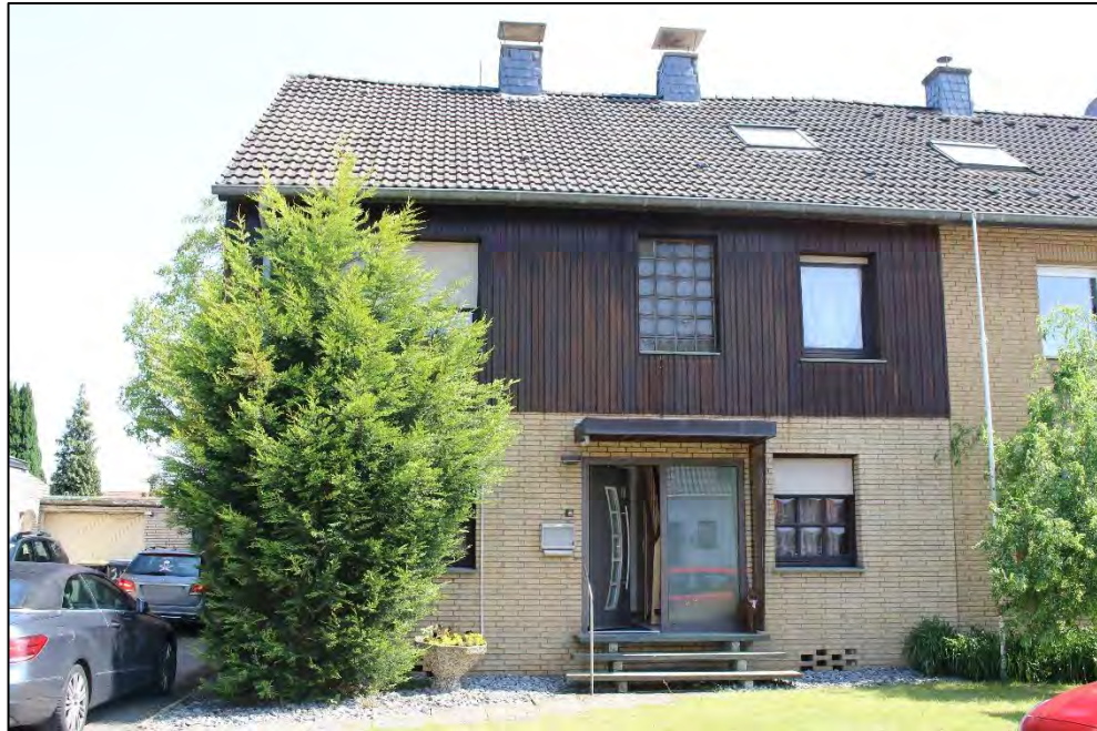
Foto Nr. 1: Straßenfassade
