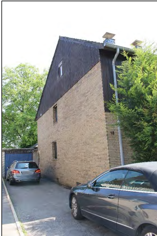
Foto Nr. 3: Seitenfassade
