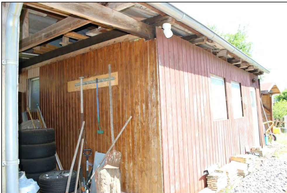
Foto Nr. 10: Nebengebäude (Sauna / WC / Dusche)
