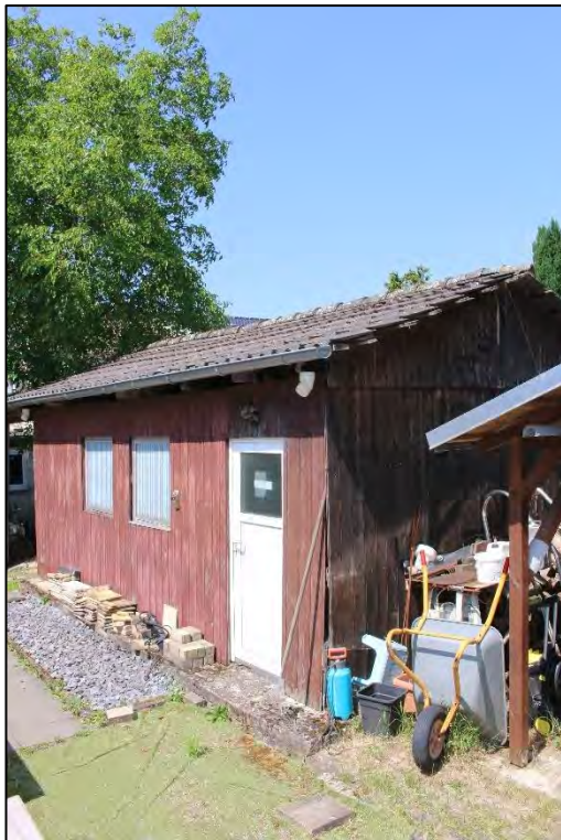
Foto Nr. 11: Nebengebäude (Sauna / WC /Dusche)
