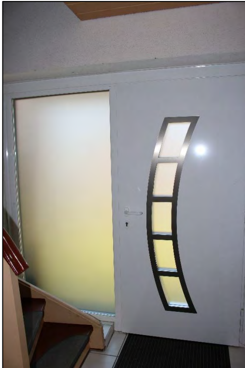
Foto Nr. 27: Erdgeschoss, Hauseingang
