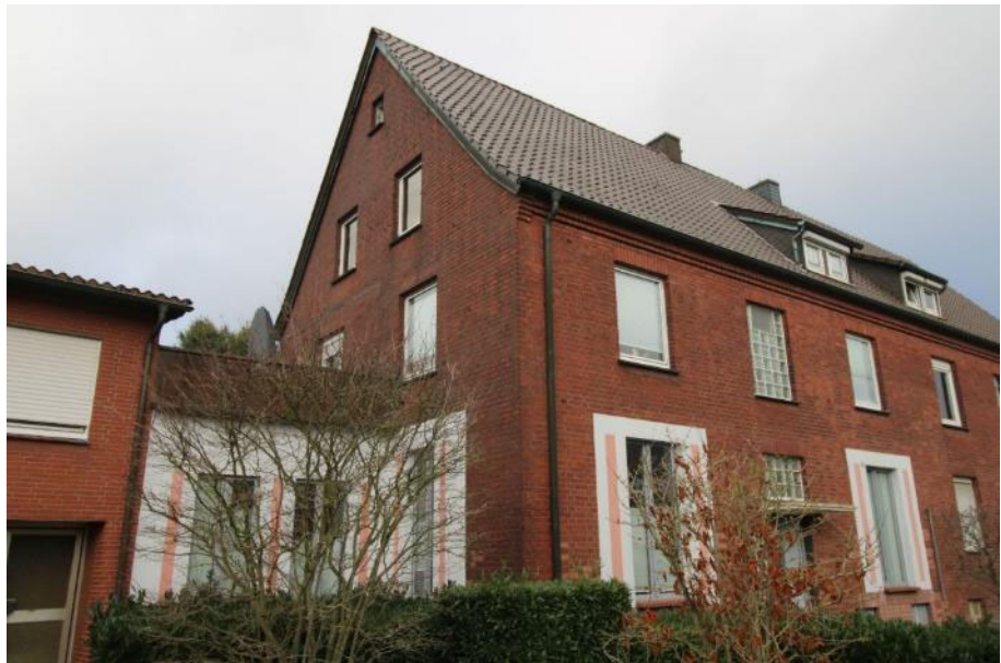
Sicht vom Gehweg aus auf die Vorder- und Giebelfassade des Dreifamilien- hauses
