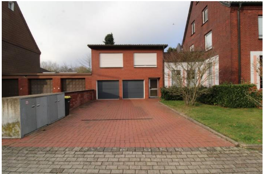
Sicht vom Gehweg aus auf die Zuwegung und die Vorderfassa- de des Garagen-Büro- gebäudes
