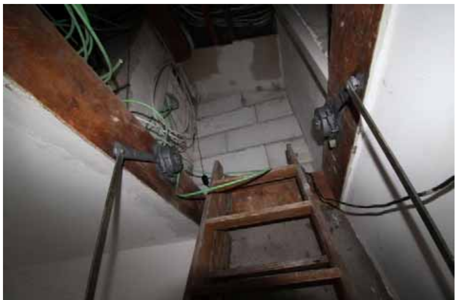
Sicht auf die Decken- luke mit Einschub- treppe zum Dachbo- den im Treppenhaus / OG
