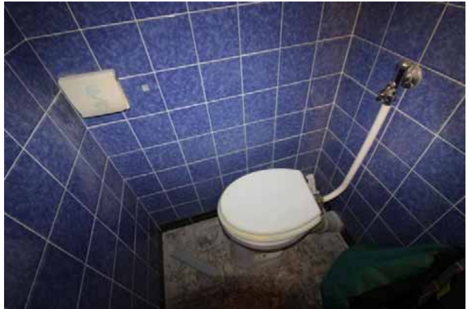
Sicht in das WC / EG links
