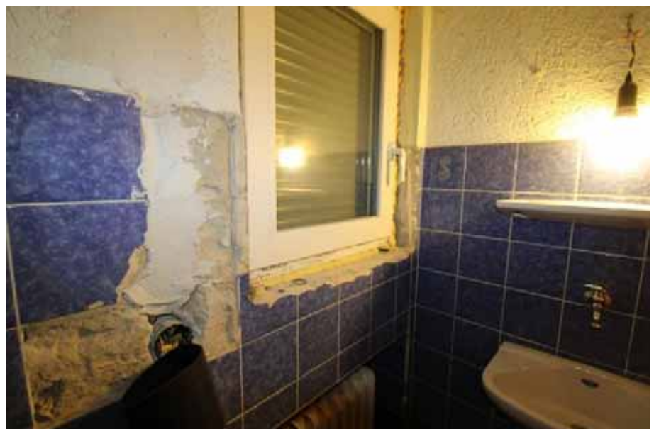
Sicht in das WC / EG links
