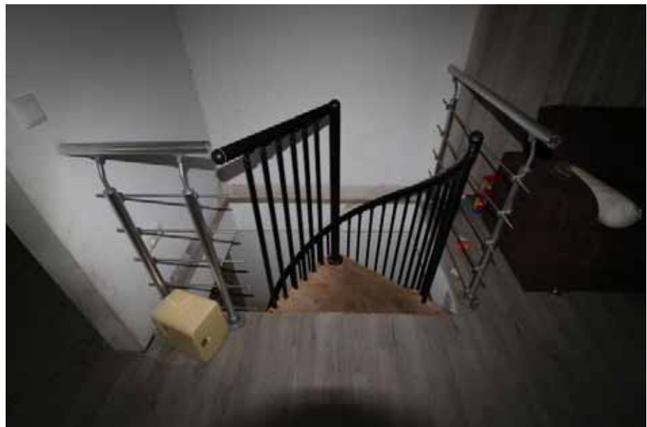
Sicht auf die interne Spindeltreppe zum EG links / OG links
