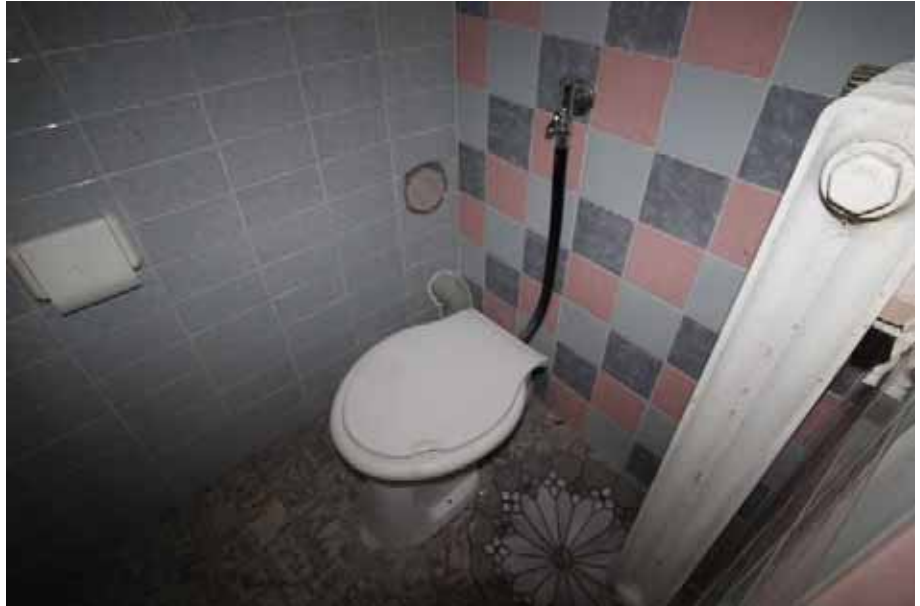
Sicht in das WC im Keller / KG
