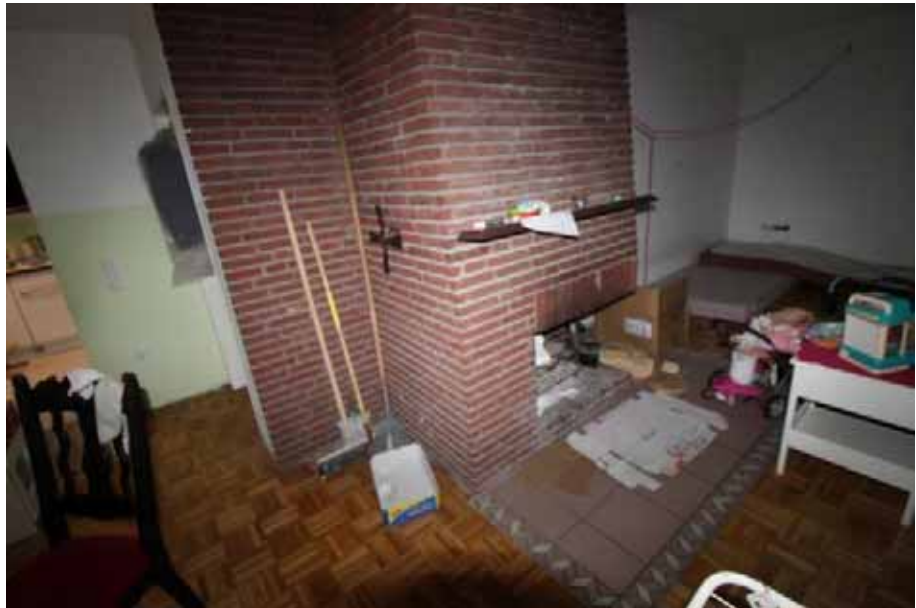
Sicht auf den Kamin im Wohnraum / EG links
