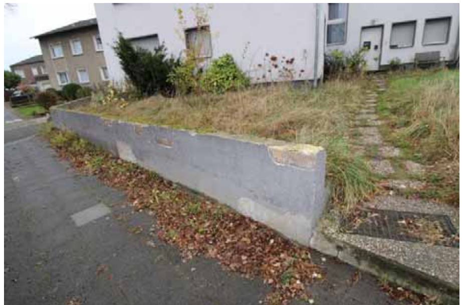
Sicht vom Gehweg der Wilhelmstraße aus auf die Einfriedung, die Zuwegung und den Vorgarten des zu bewertenden Objekts
