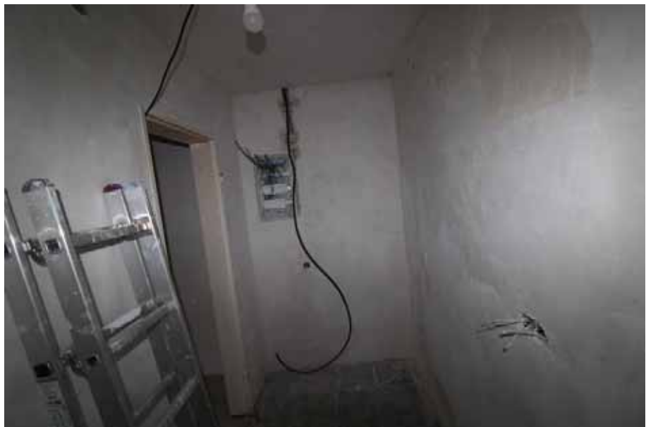
Sicht in einen Raum / OG rechts
