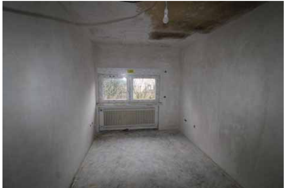
Sicht in einen Raum / OG rechts
