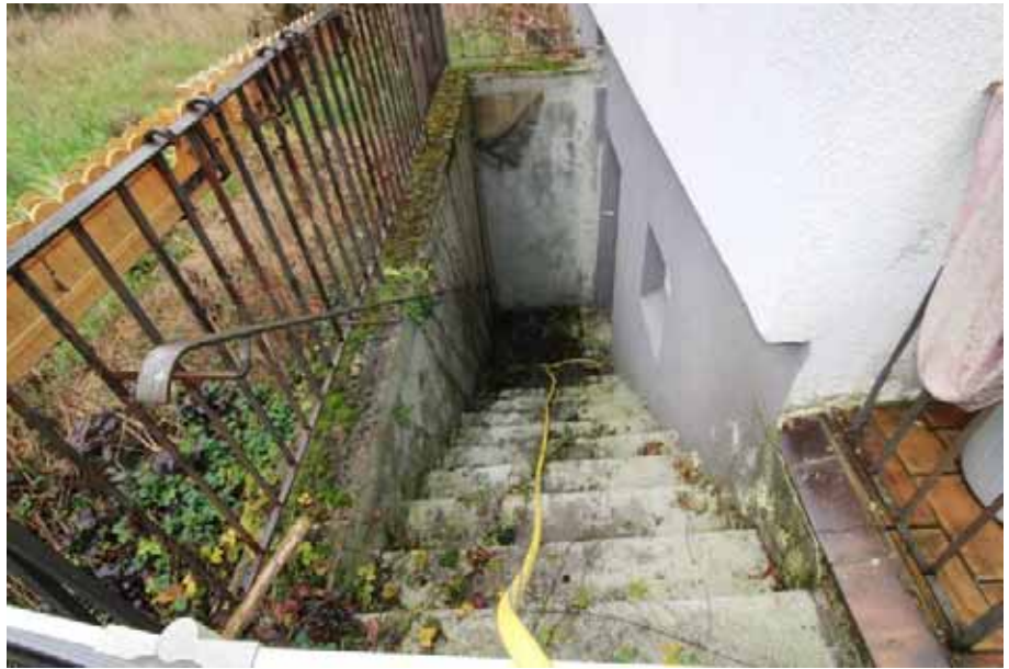
Sicht auf die Keller- außentreppe des zu bewertenden Objekts
