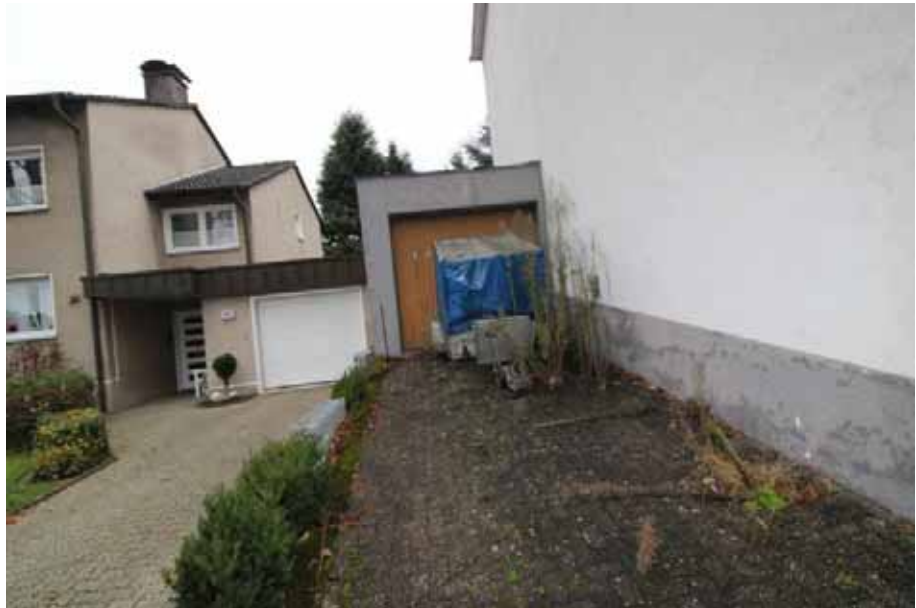
Sicht von der Wilhelmstraße aus auf die Zufahrt zur Pkw-Garage des zu bewertenden Objekts
