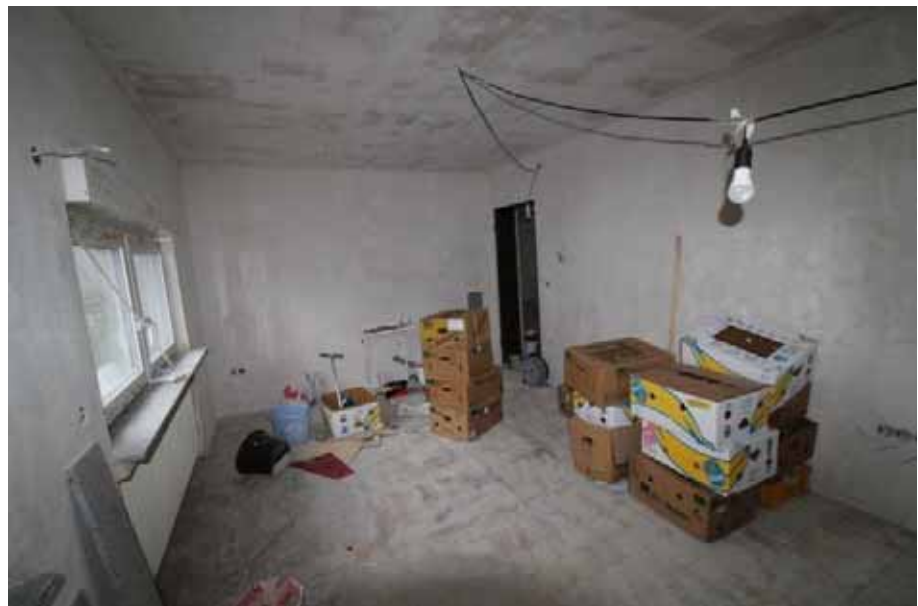
Sicht in einen Raum / OG rechts
