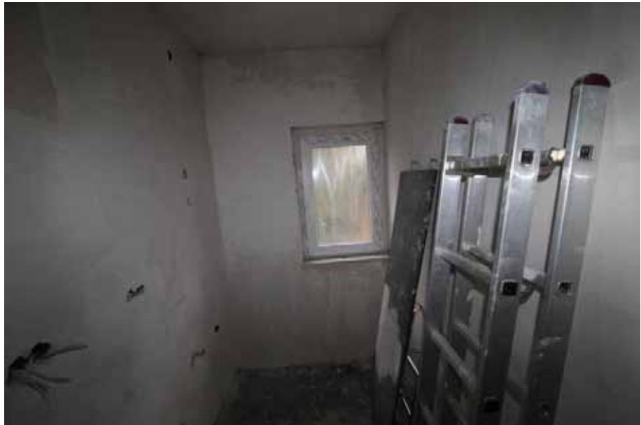
Sicht in einen Raum / OG rechts
