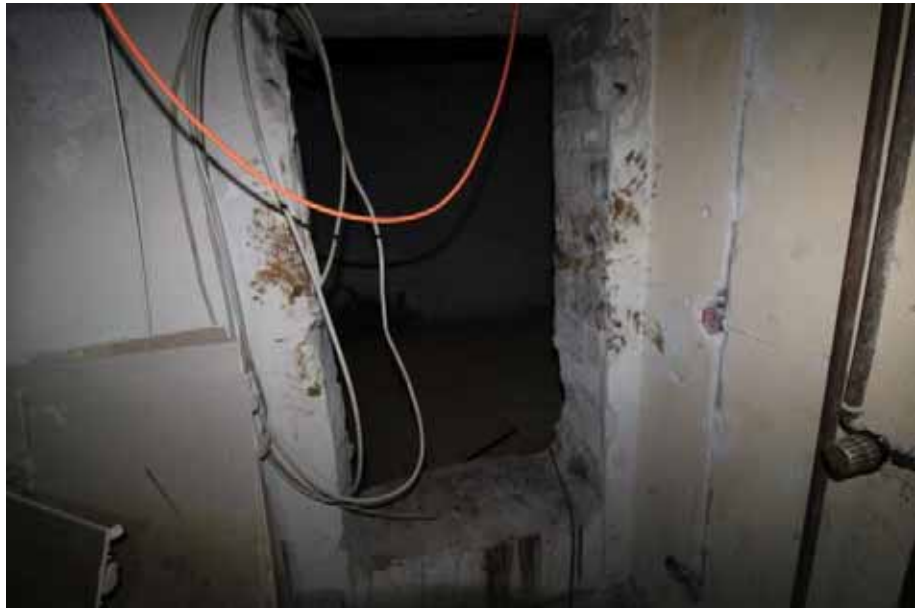
Sicht auf den Zugang zum ehemaligen Öltankraum / KG
