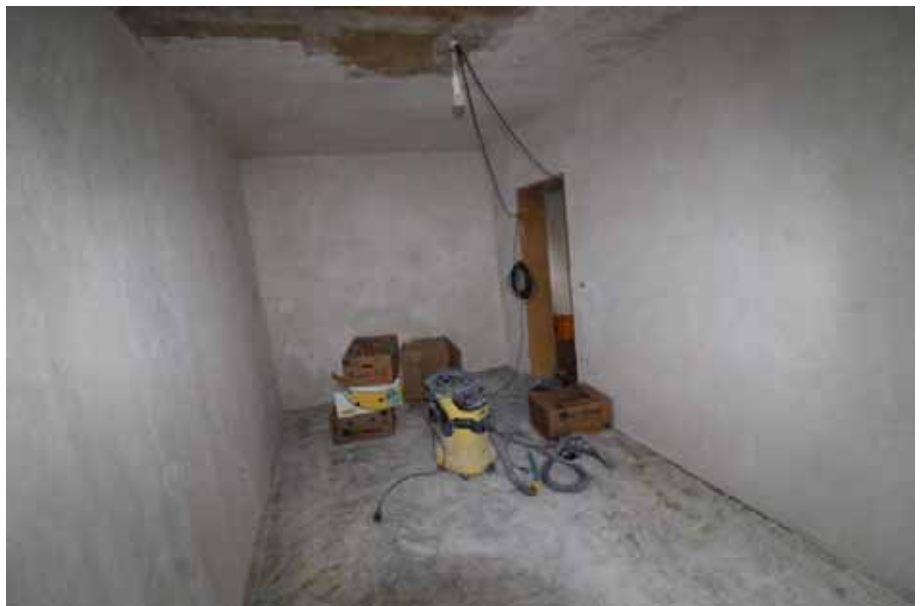
Sicht in einen Raum / OG rechts
