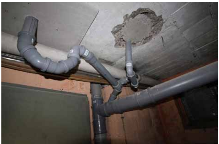
Sicht auf die Ent- wässerungsleitungen in einem Kellerraum / KG
