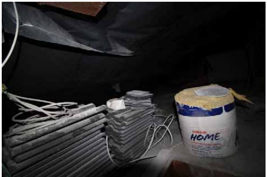
Sicht in den Dachboden / DG
