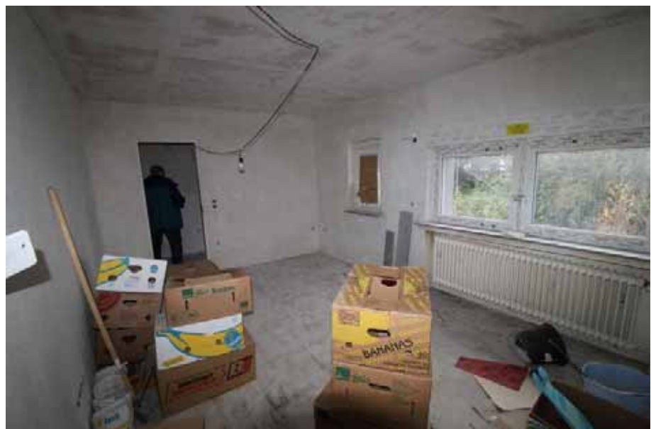
Sicht in einen Raum / OG rechts
