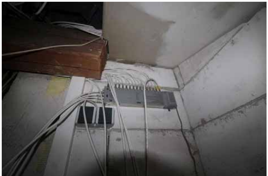
Sicht in den Dachboden / DG
