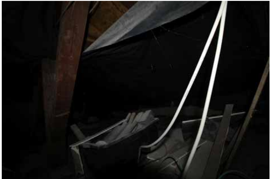
Sicht in den Dachboden / DG
