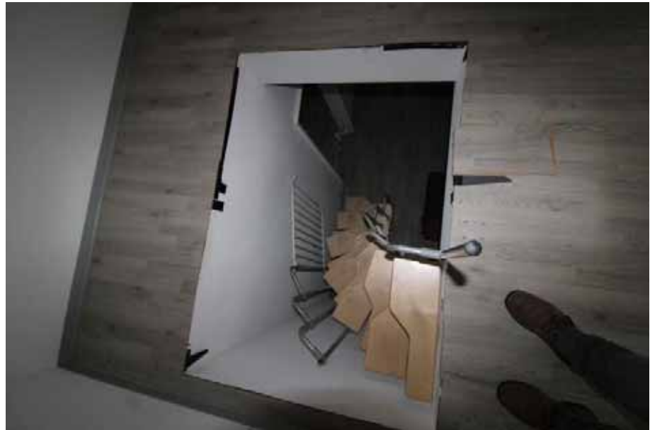
Sicht auf die Raumspartreppe vom DG zum OG / DG links
