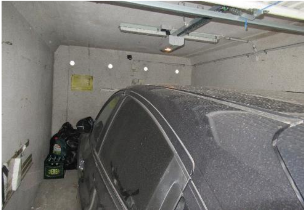
Einblick in die Stahlbetonfertigggarage
