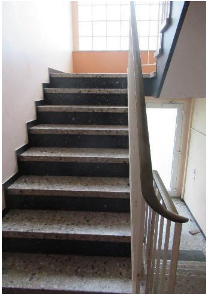
Geschosstreppe im Erdgeschoss
