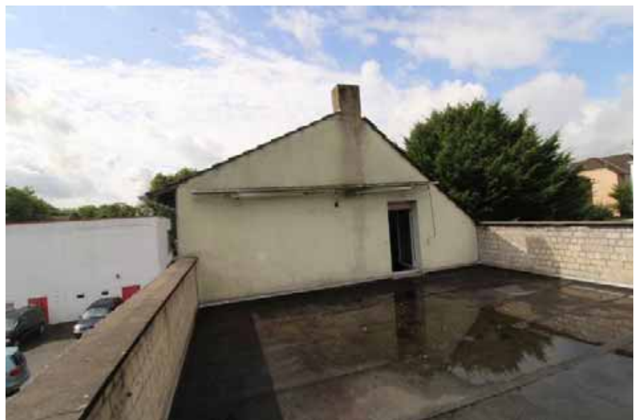
Sicht auf die rechte Giebelseite mit Zugang zum Flachdach des Nebengebäudes / OG
