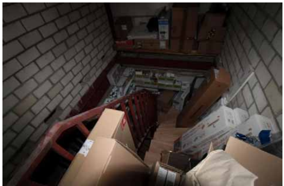
Sicht in das Treppen- haus / OG
