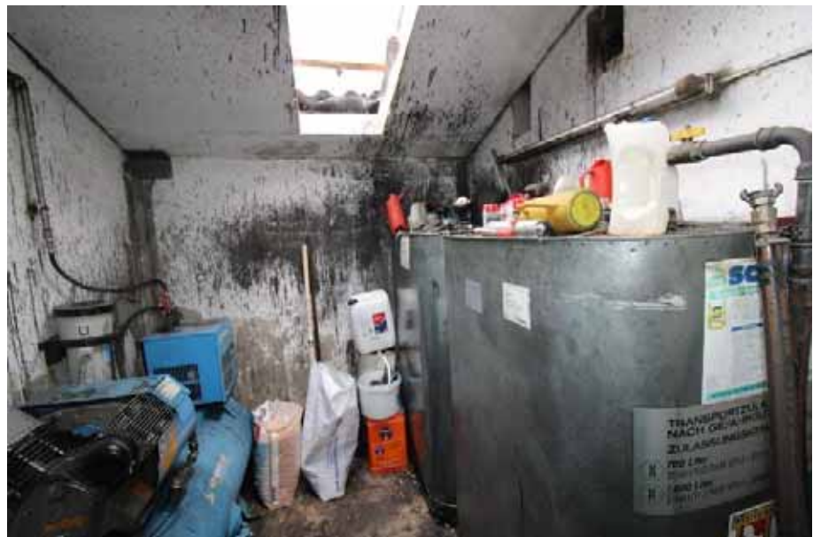
Sicht in das Lager 1 im Nebengebäude zur Werkstatt
