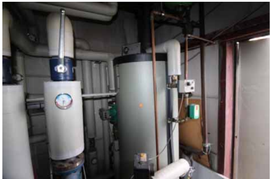
Sicht in den Heizungsraum / EG links
