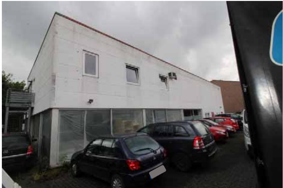
Sicht vom Hof auf die Rückseite des vorderen Gebäudes des zu bewertenden Objekts
