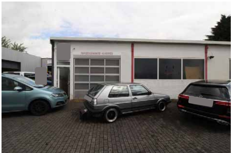
Sicht auf die Kfz-Halle mit Büroraumanbau im Hof
