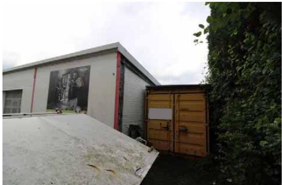
Sicht auf die Vorderansicht der Kfz-Halle im Hof
