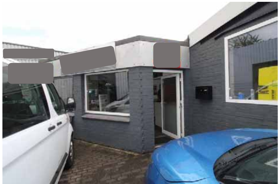
Sicht auf den Eingang zum Büroraumanbau der Kfz-Halle im Hof
