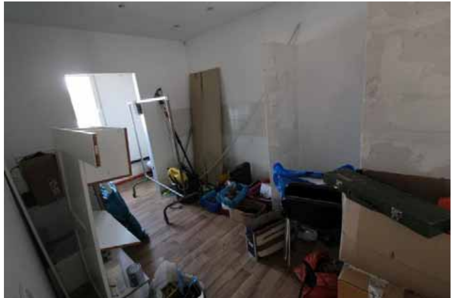
Sicht in die Küche mit Zugang zum WC / OG
