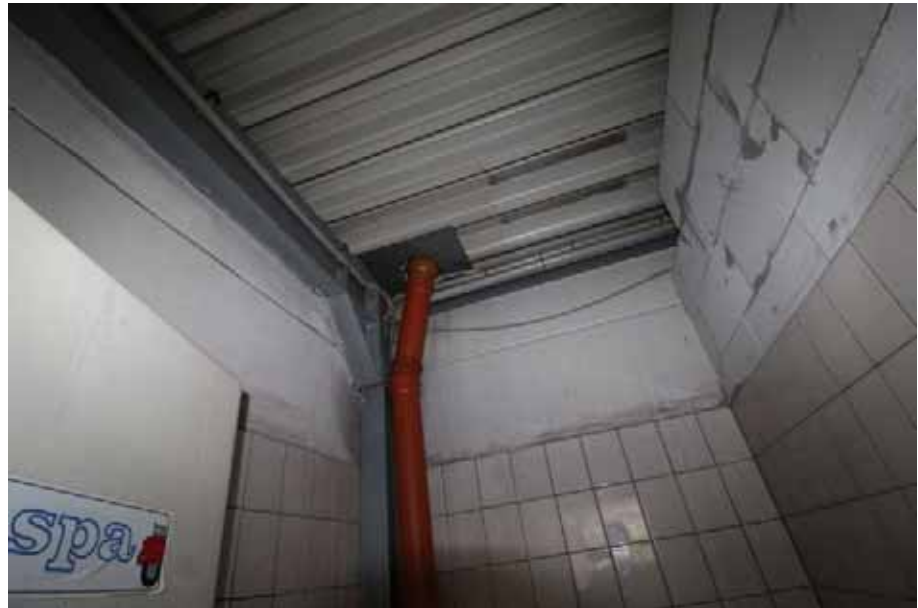
Sicht auf die Decke und die Innenentwässerung in einem WC / OG
