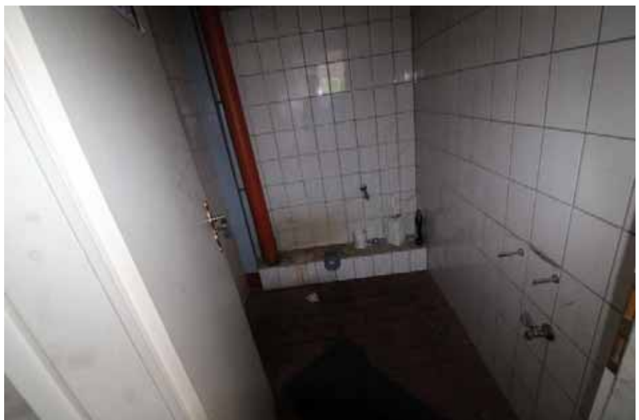
Sicht in ein WC / OG
