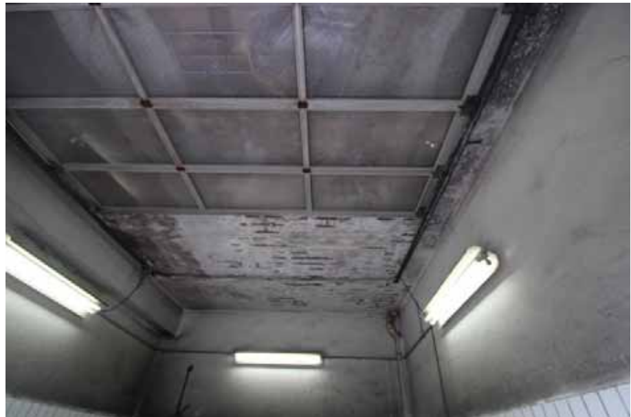
Sicht in auf das Sektionaltor des Arbeitsraums 2 im Nebengebäude zur Werkstatt
