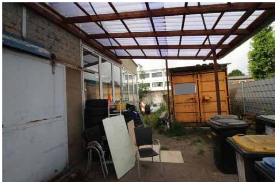
Sicht auf den überdachten Lagerbereich an der Rückseite der Werkstatt
