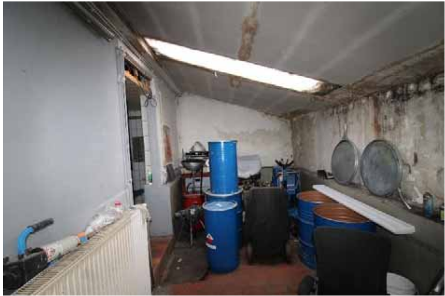
Sicht in das Lager 2 im Nebengebäude zur Werkstatt
