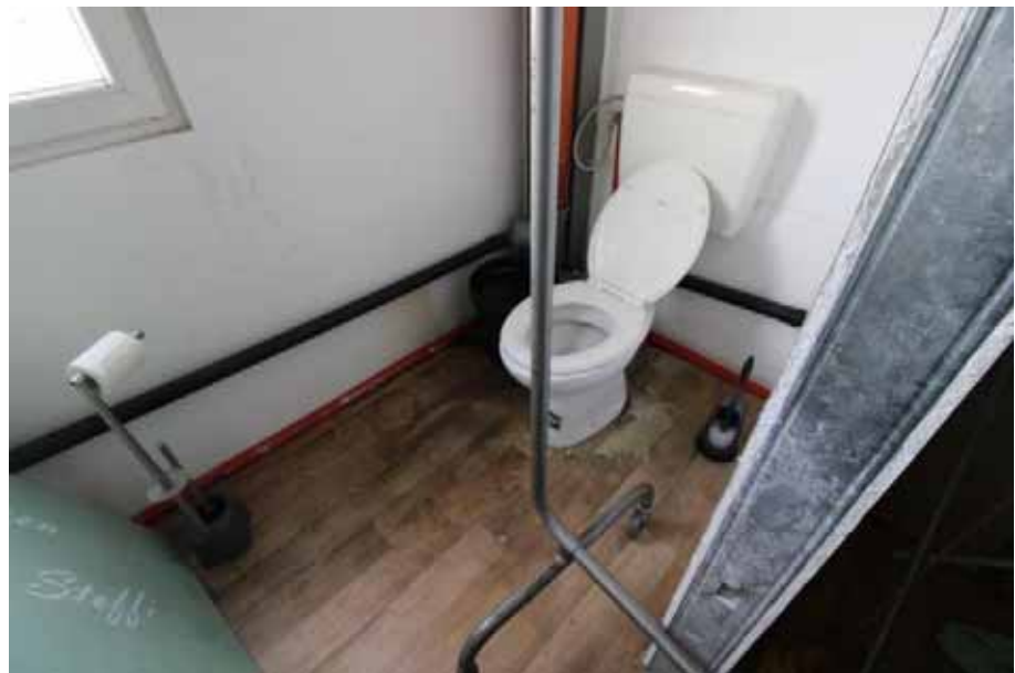
Sicht in das WC hinter der Küche / OG
