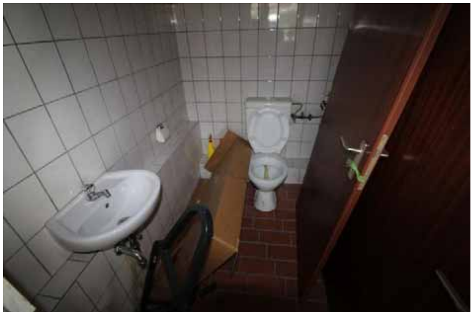
Sicht in ein WC / OG
