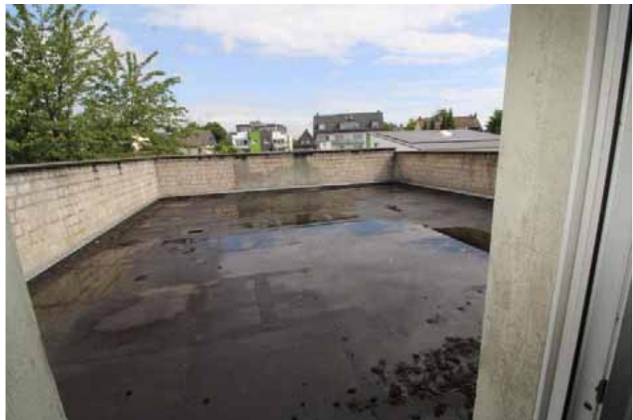
Sicht auf das Flachdach des Nebengebäudes / OG
