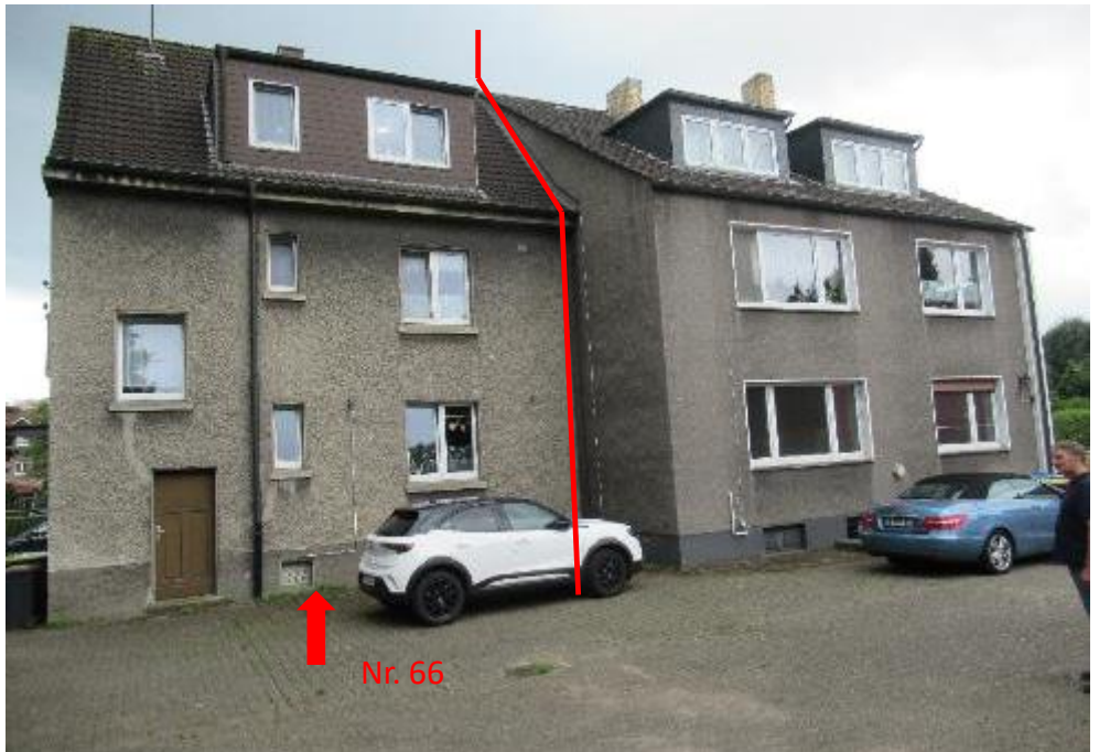
Hofansicht Schulstraße 66 und 66a
