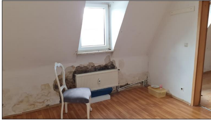
34) Zimmer/ Schäden hinter der Heizung
