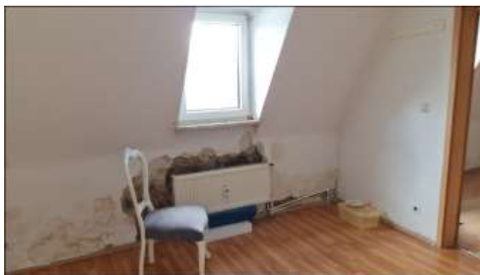
34) Zimmer/ Schäden hinter der Heizung
