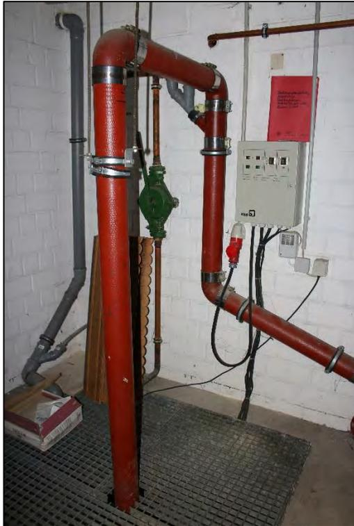
Foto Nr. 17: Kellergeschoss, Kellerraum mit Fäkalienhebeanlage
