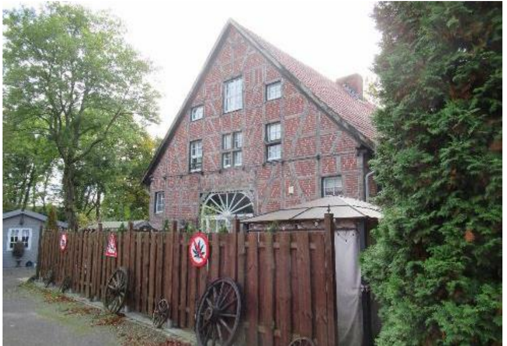
Giebelansicht von der Bockholter Straße
