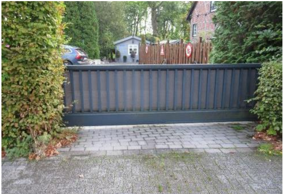
elt. betriebene Stahltoranlage zum Hof
