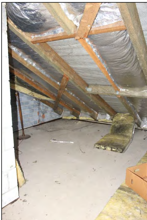
Foto Nr. 32: Einfamilienreihenendhaus, Dachboden
