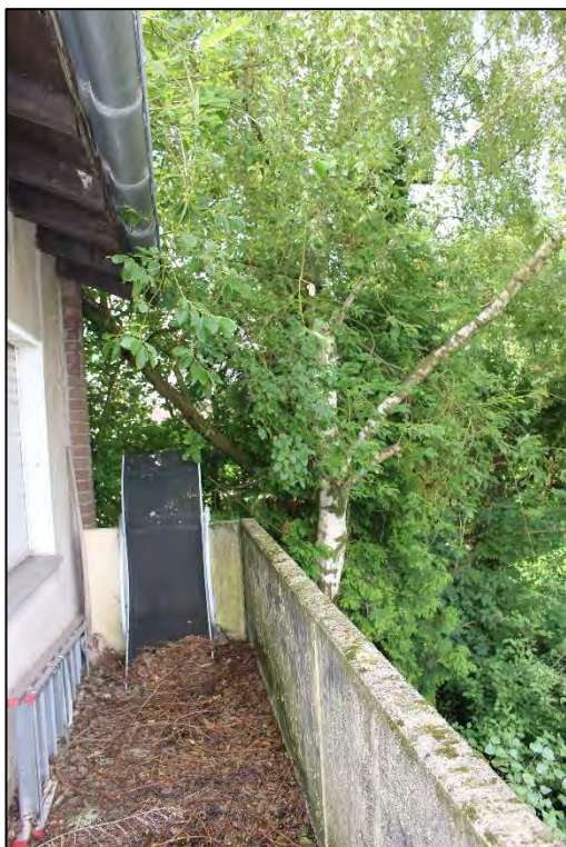
Foto Nr. 22: Einfamilienreihenendhaus, Obergeschoss, Balkon
