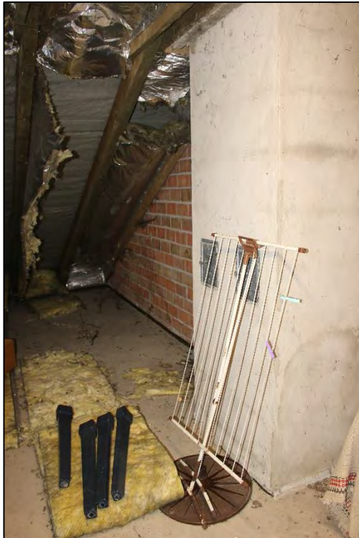
Foto Nr. 31: Einfamilienreihenendhaus, Dachboden
