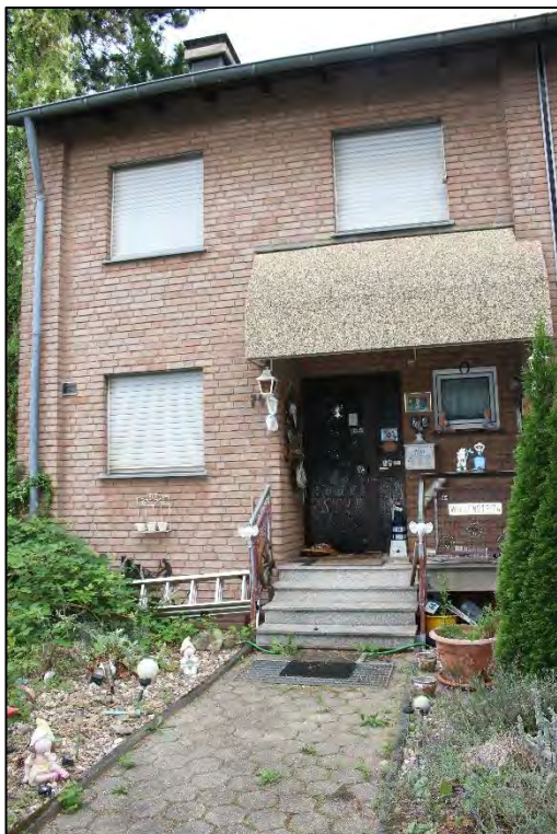
Foto Nr. 1: Eingangsfassade
