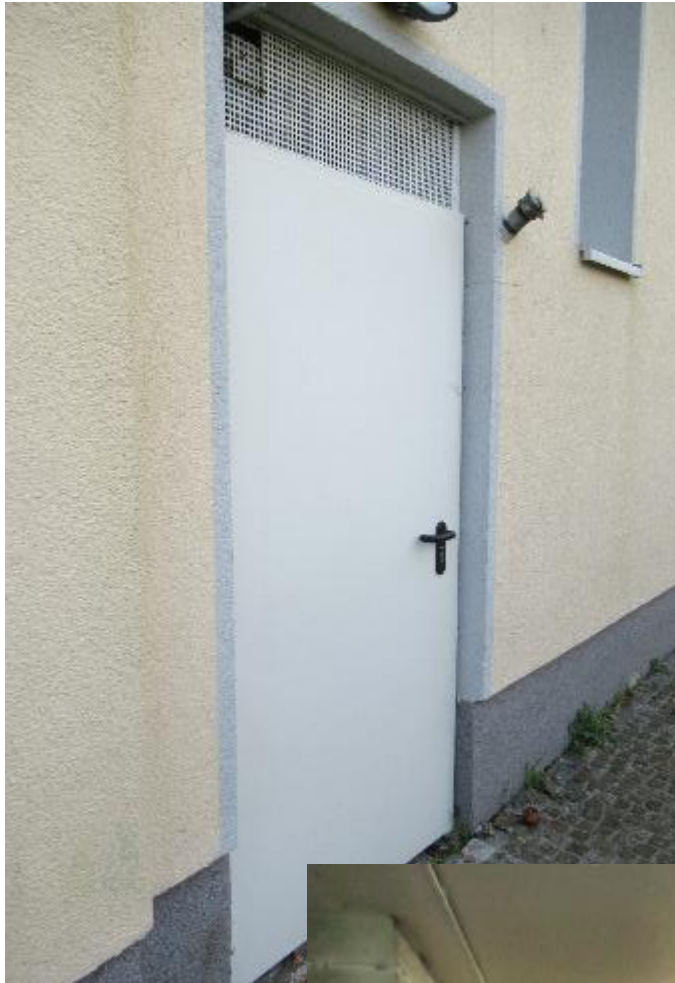
Außentür zum Heizungsraum
