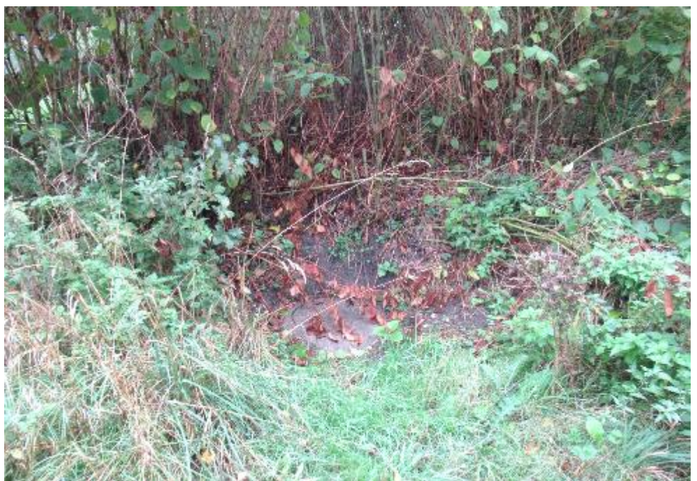
Deckel der Kleinkläranlage
