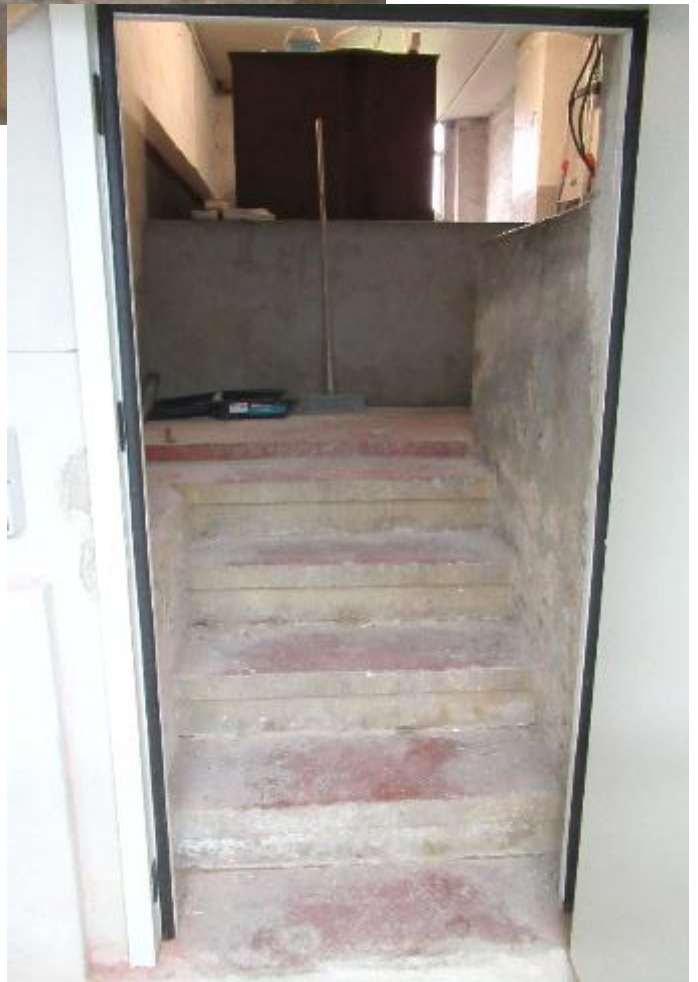
Treppe zum Kellergeschoss
