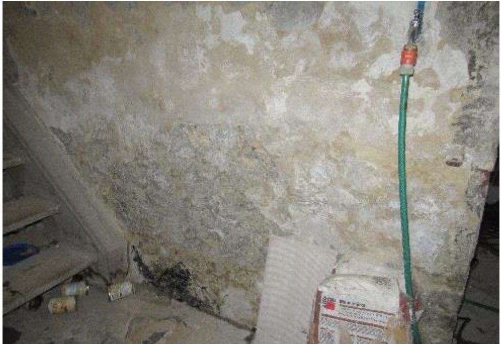
Durchfeuchtungen im Bereich der Treppe
