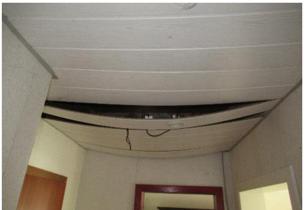
Schäden an der Decke
