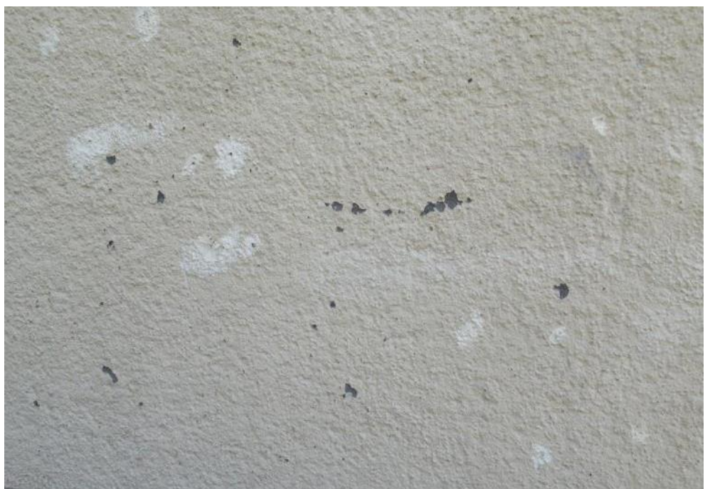
Abplatzungen am Außenputz
