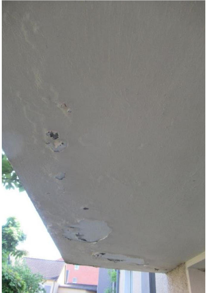
Durchfeuchtung am Balkon
