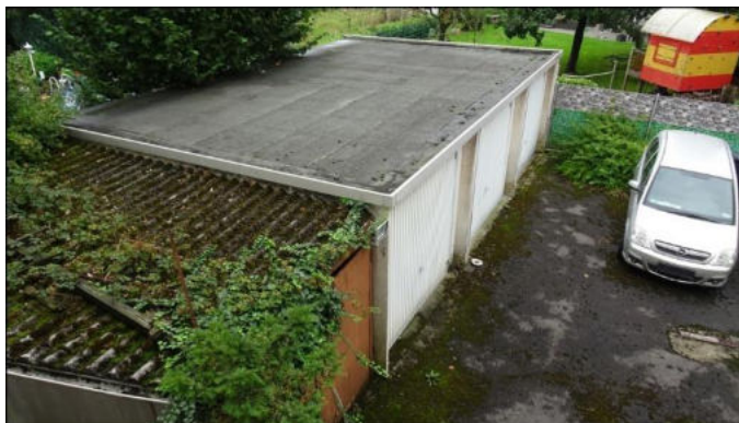
16) Blick in den Hof und auf die Garagen
