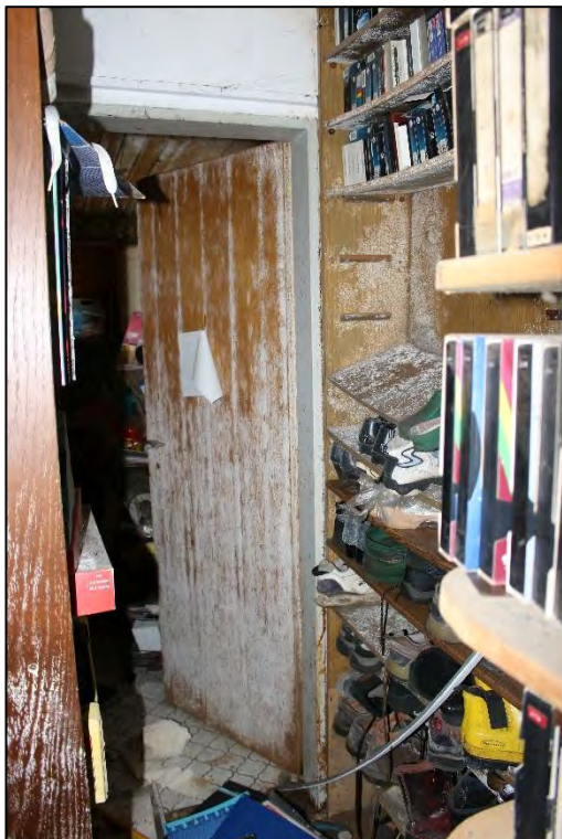
Foto Nr. 50: Kellergeschoss, Zugang Kinderzimmer
