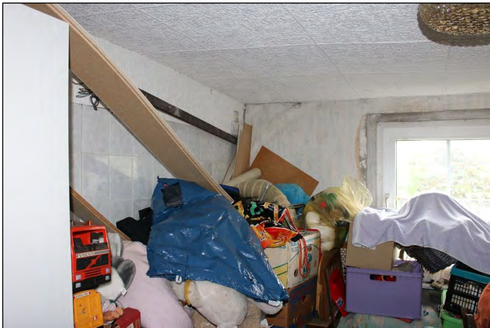
Foto Nr. 40: Dachgeschoss, ehemaliges Bad
