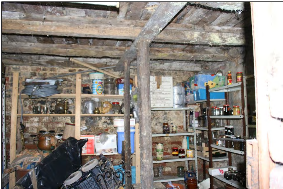
Foto Nr. 64: Kellergeschoss, Kellerraum
