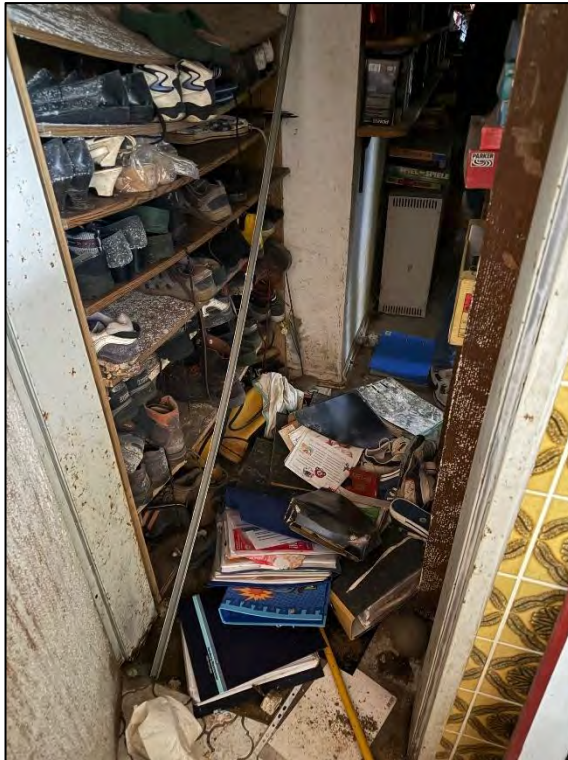
Foto Nr. 47: Kellergeschoss, Flur
