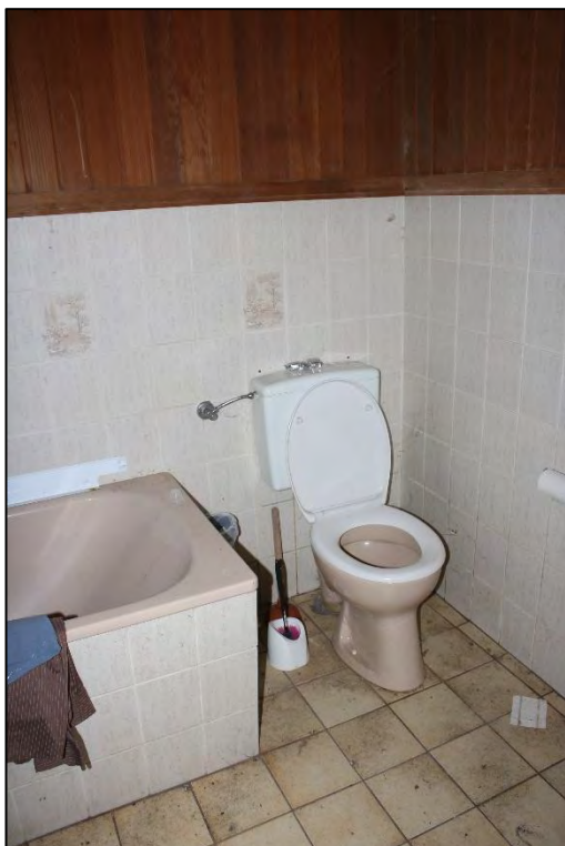
Foto Nr. 56: Kellergeschoss, Bad
