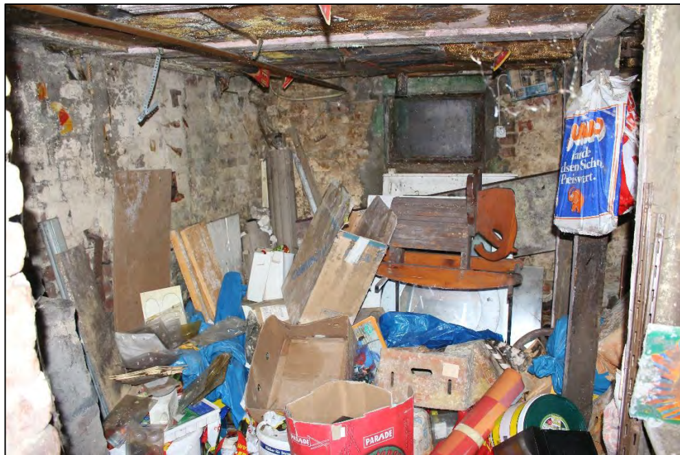
Foto Nr. 61: Kellergeschoss, Kellerraum
