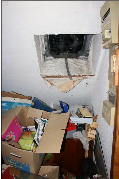
Foto Nr. 37: Dachgeschoss, Abstellraum / Elektrounterverteilung
