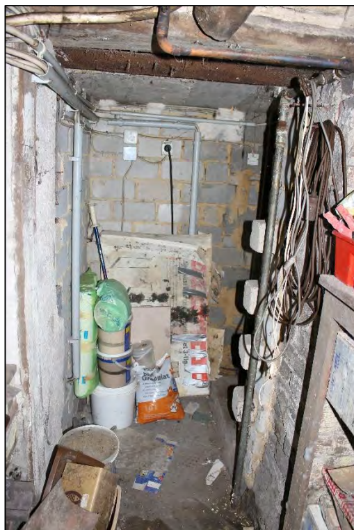
Foto Nr. 62: Kellergeschoss, Kellerraum
