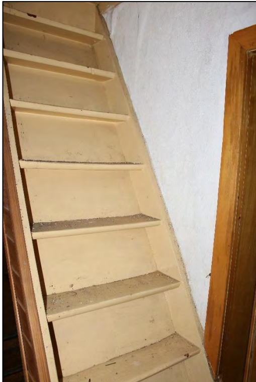
Foto Nr. 41: Dachgeschoss, Treppe zum Spitzboden
