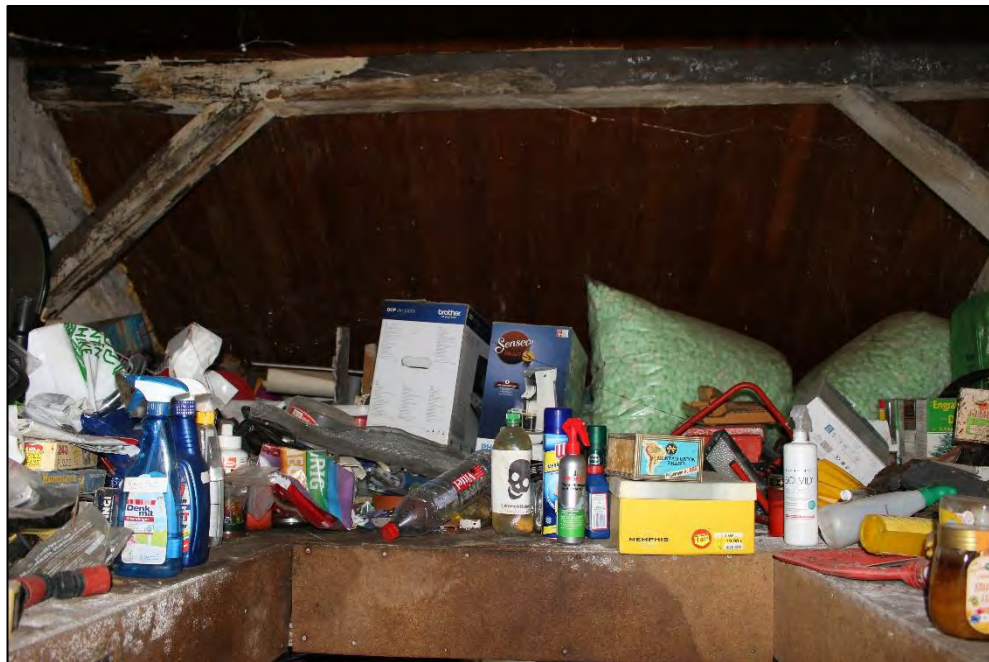
Foto Nr. 59: Kellergeschoss, oberhalb Zugang Schlafräume
