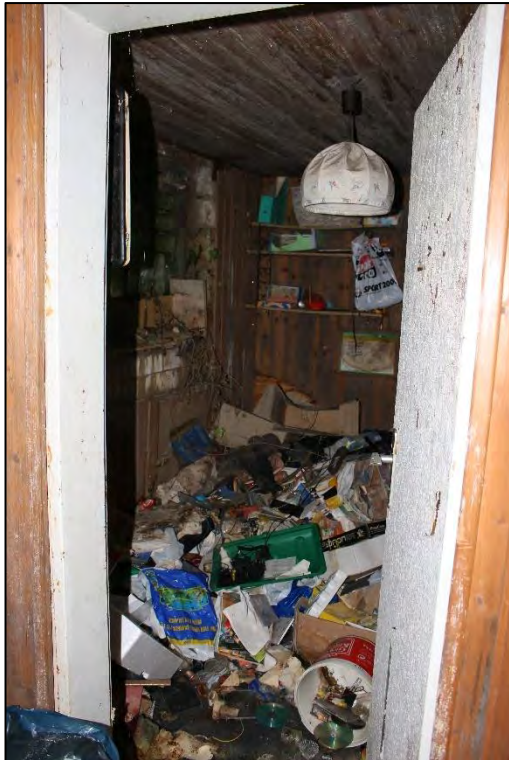
Foto Nr. 51: Kellergeschoss, ehemalige Küche
