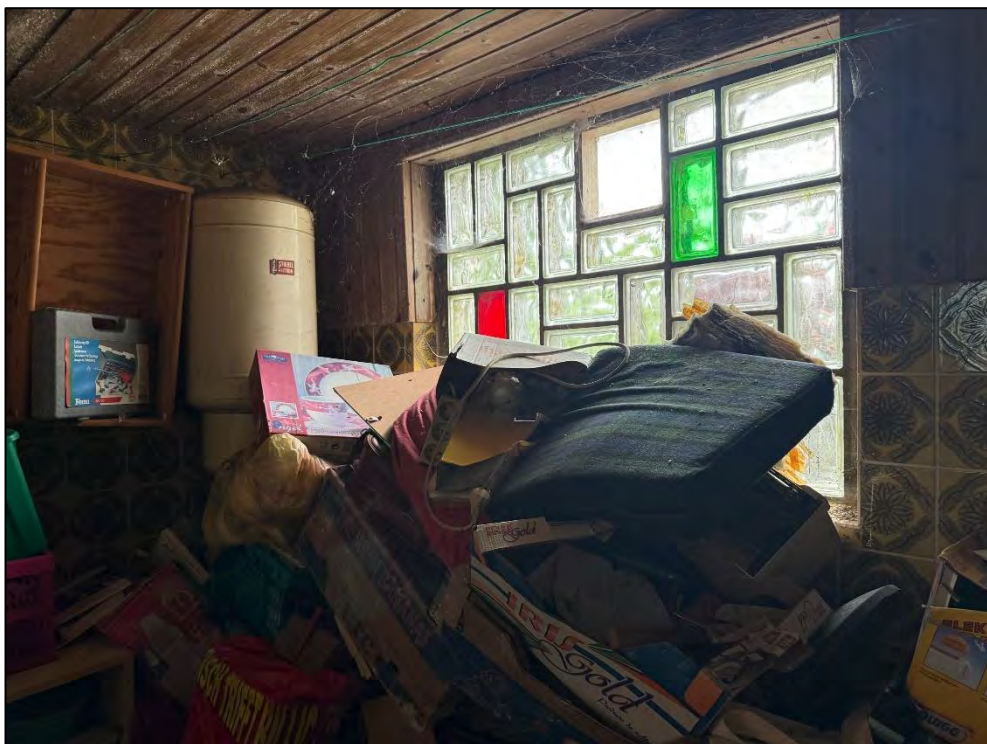
Foto Nr. 46: Kellergeschoss, Bad
