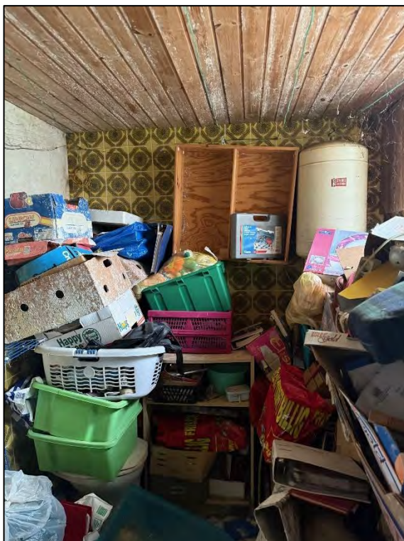
Foto Nr. 44: Kellergeschoss, Bad
