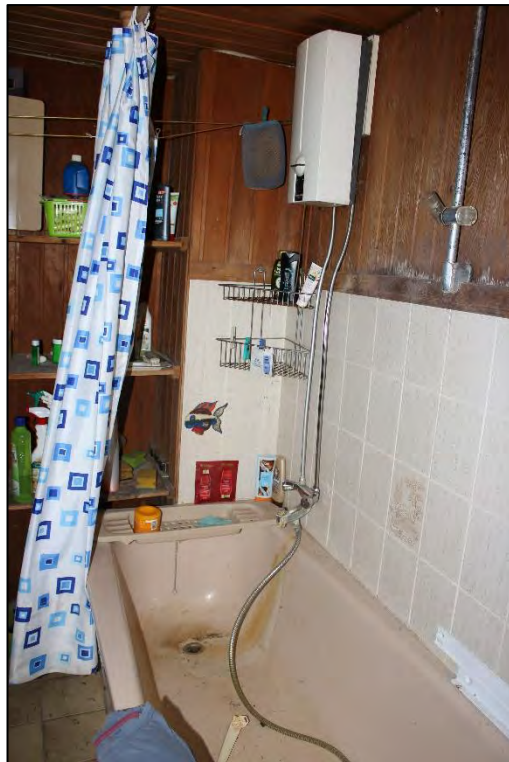
Foto Nr. 57: Kellergeschoss, Bad
