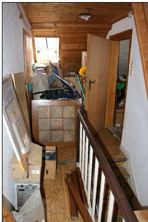
Foto Nr. 34: Dachgeschoss, Flur
