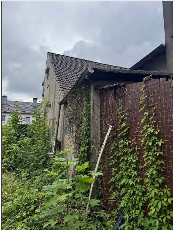
Foto Nr. 11: Seitenfassade
