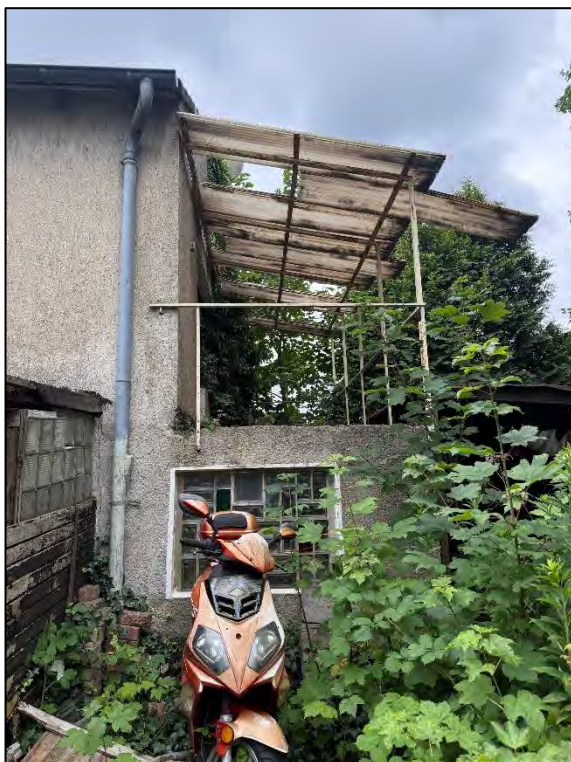
Foto Nr. 10: Seitenfassade
