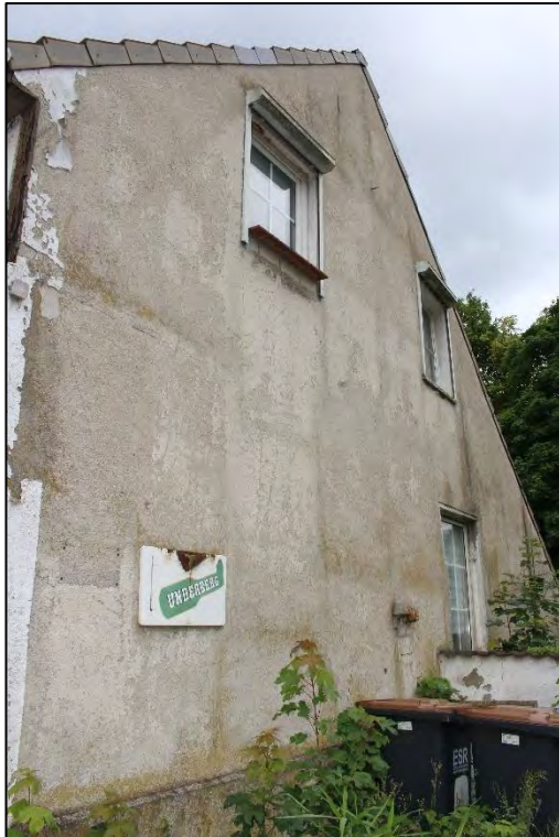
Foto Nr. 3: Seitenfassade
