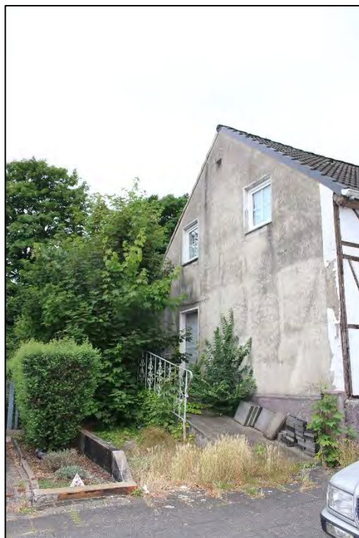
Foto Nr. 6: Seitenfassade / Rampe
