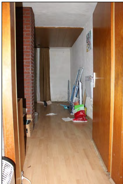
Foto Nr. 22: Erdgeschoss, Zugang zum Wohnraum
