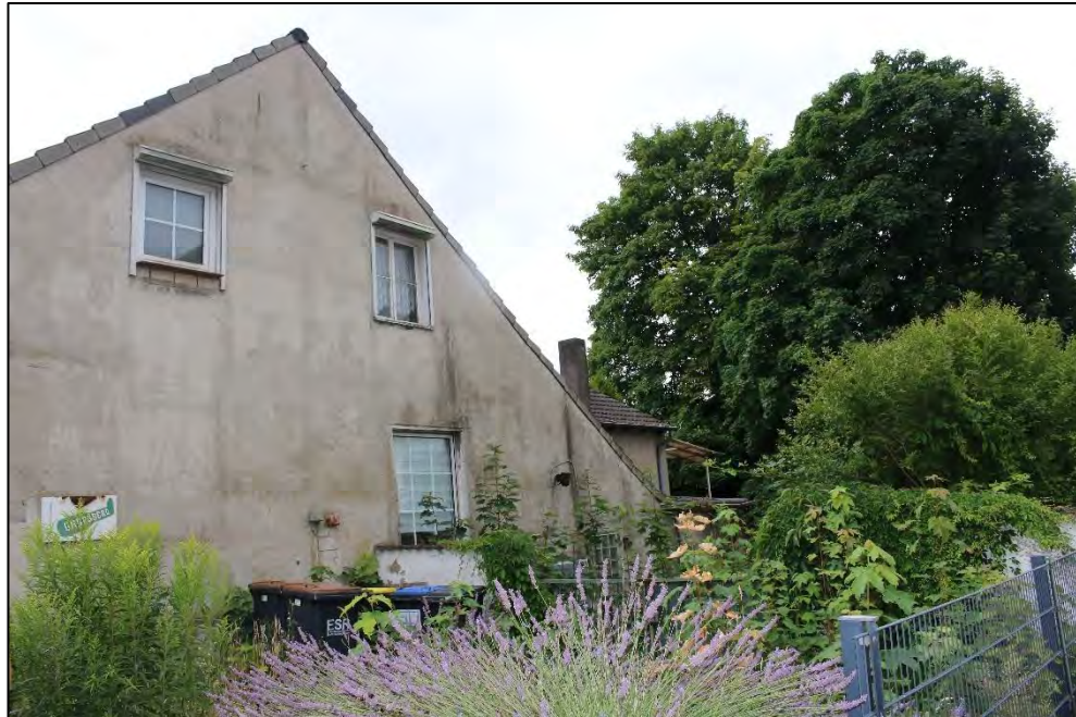
Foto Nr. 5: Seitenfassade
