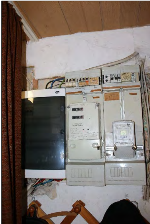
Foto Nr. 13: Erdgeschoss, Eingangsbereich
