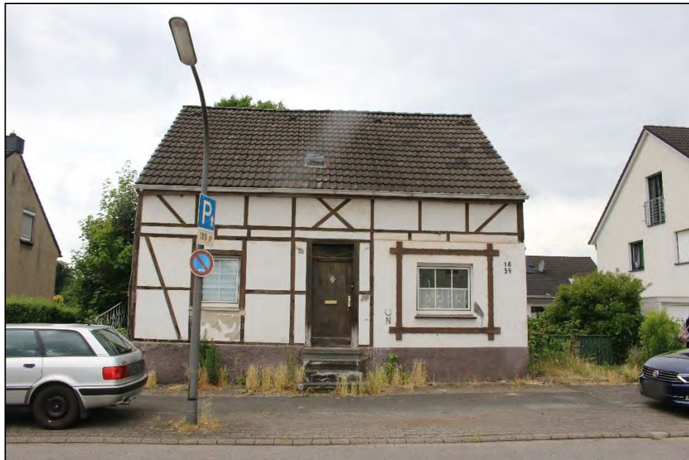
Foto Nr. 1: Straßenfassade
