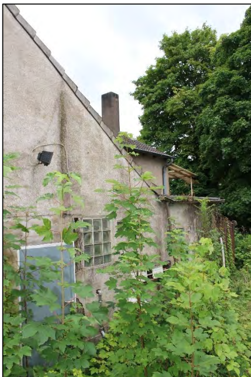
Foto Nr. 4: Seitenfassade
