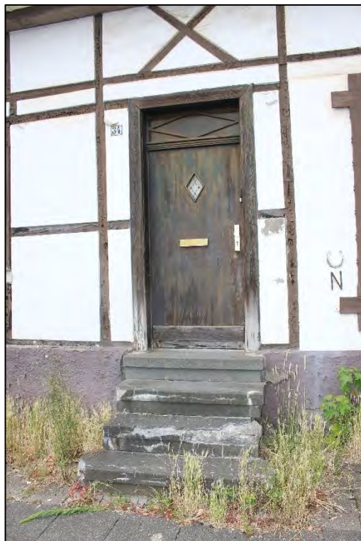
Foto Nr. 2: Hauseingang
