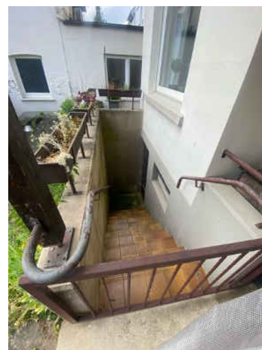
Zugang zum Kellergeschoß
