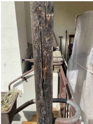
Witterungseinflüsse Holzstütze
