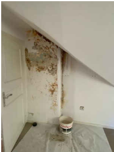
Feuchteschaden Schornstein
