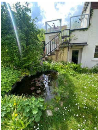
Hinterer Teil des Anbaus
