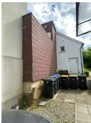
Ansicht von Nord-Westen/Anbau
