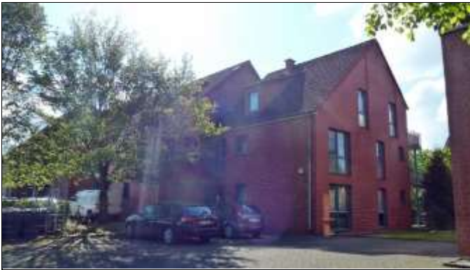
-1- Straßenansicht von Nordwesten
