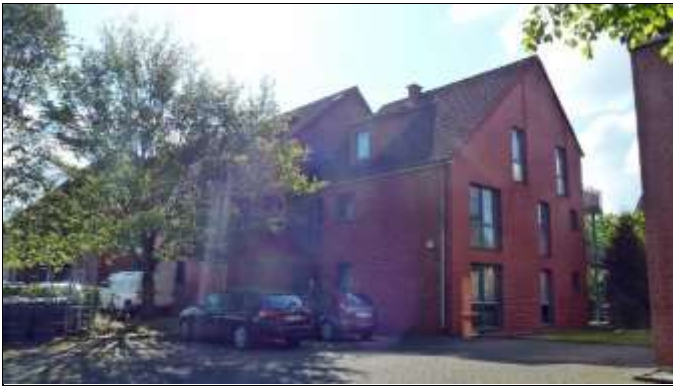
-1- Straßenansicht von Nordwesten
