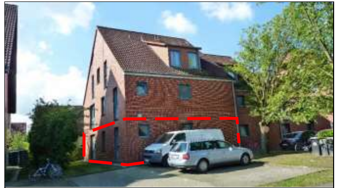
-2- Straßenansicht von Nordosten
