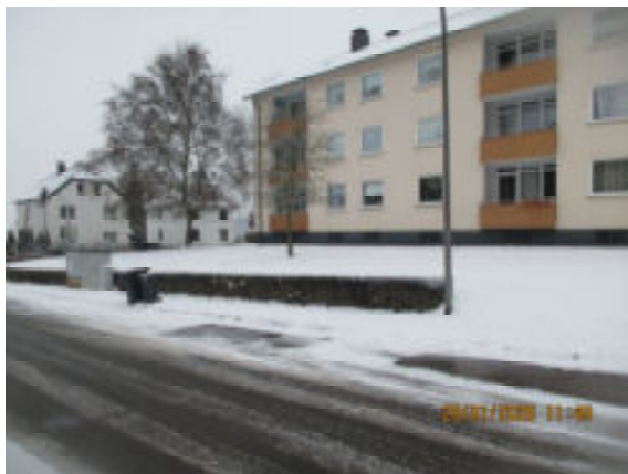
Westansicht, Dachsstraße im Vordergrund
