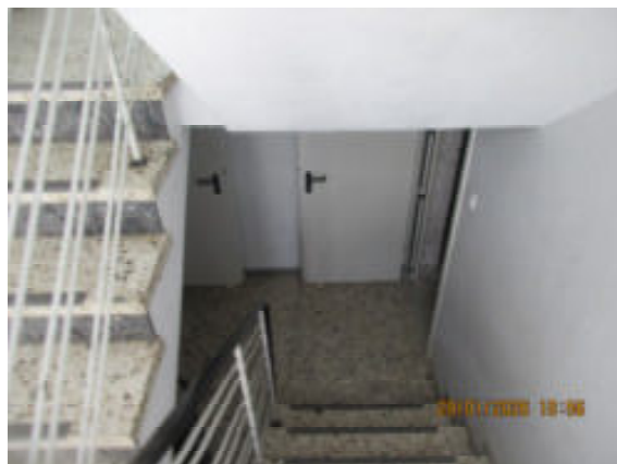
Treppe zum Kellergeschoss
