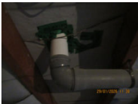
Abdichtung Lüftungsrohr
