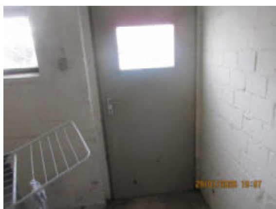
Trockenkeller mit Außentür
