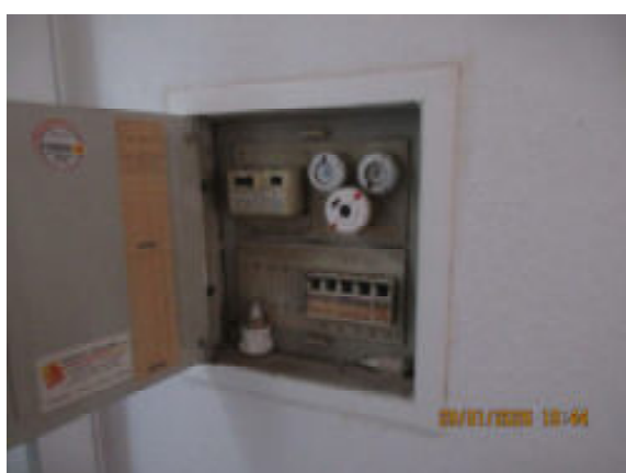
Unterverteilung mit Dreh- und Kippsicherungen
