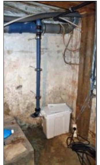
-17- SW-Hebeanlage
