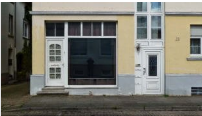
-6- Ladenfront, Hauseingang Wohnungen 2 und 3
