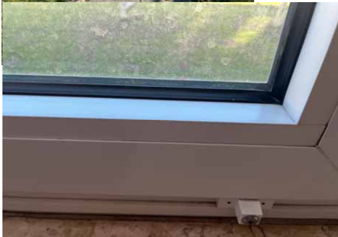
Kunststoff-Fenster im Treppenhaus
