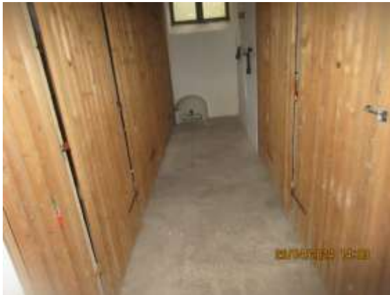
Flur mit Kellerräumen rechts u. links
