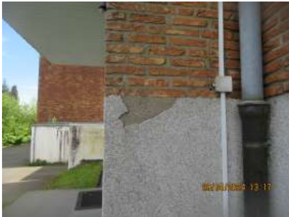
Schadhafter Sockelputz
