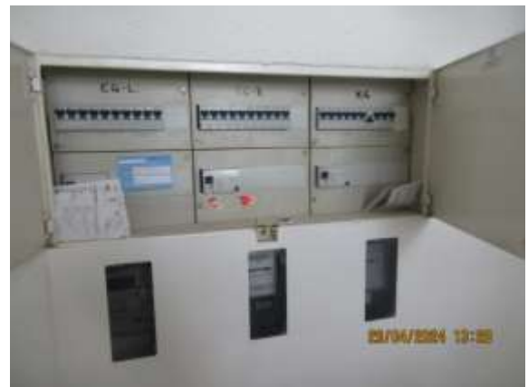
Unterverteilung /Zählerkasten
