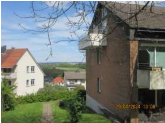
Blickrichtung Norden /Nordwestfassade
