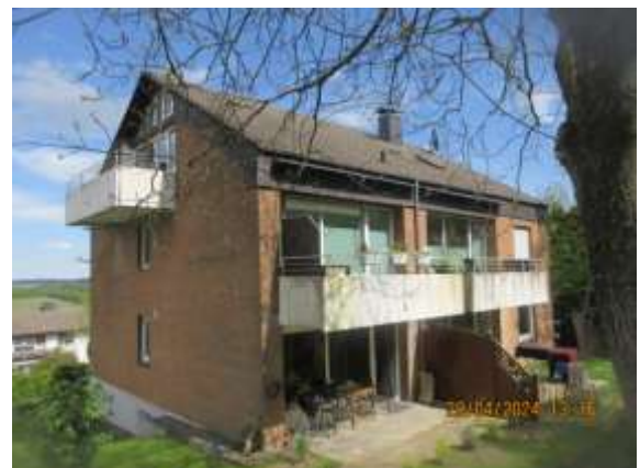
Blick von Südwesten
