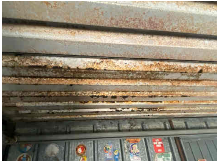
Korrosionsschäden in Garage
