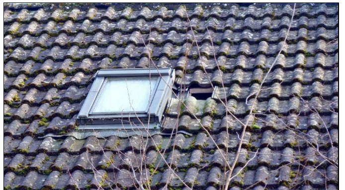
-15- Fehlstelle Dacheindeckung
