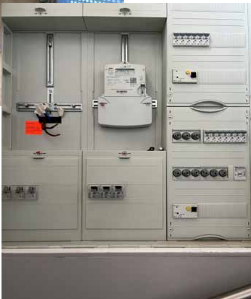
Sanierte Elektrische Hauptverteilung
