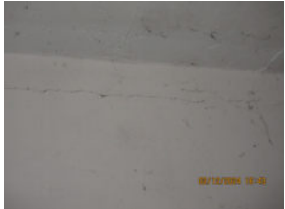
waagerechter Riss
