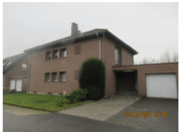
Straßenansicht / Blickrichtung Südosten
