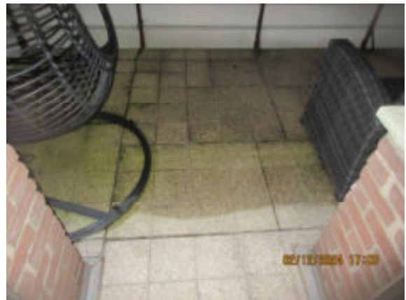
schadhafter Fliesenbelag
