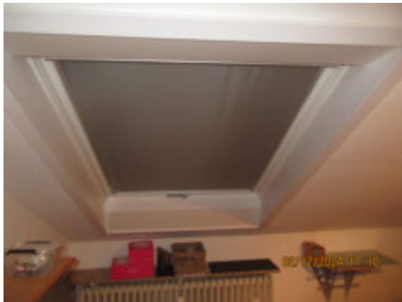
Dachflächenfenster im Zimmer
