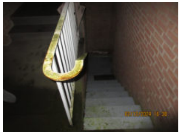
Algenansatz am Treppengeländer und auf den Stufen
