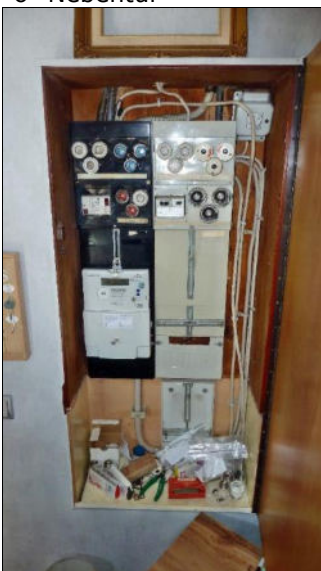
-8- Stromzählerkasten
