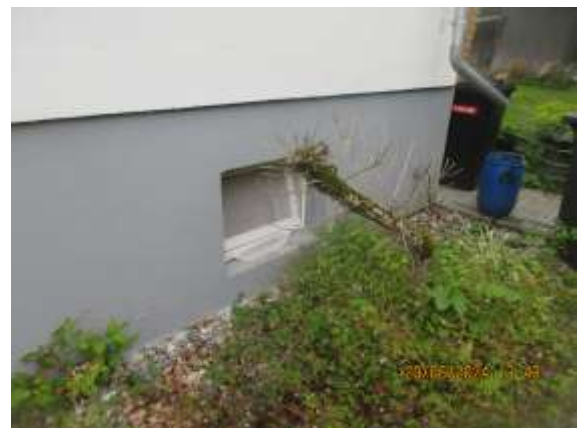
Regenfallrohr / nicht angeschlossen
