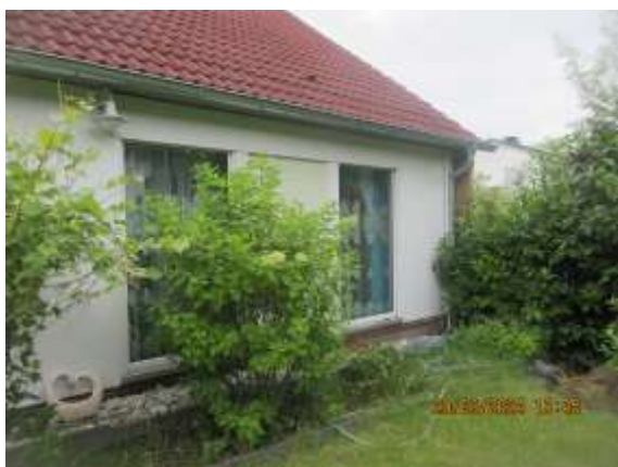
Fassade SW / Wohnzimmerfenster
