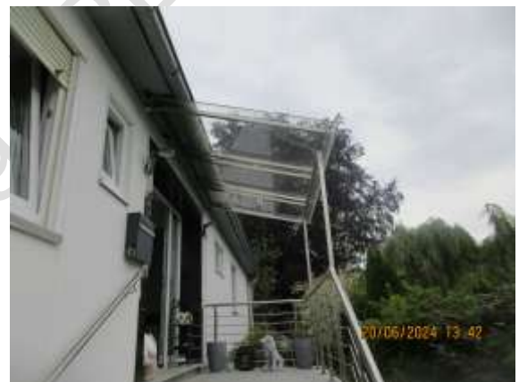
Überdachter Hauseingang / NO
