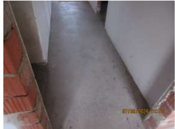
Flur – Blickrichtung Norden
