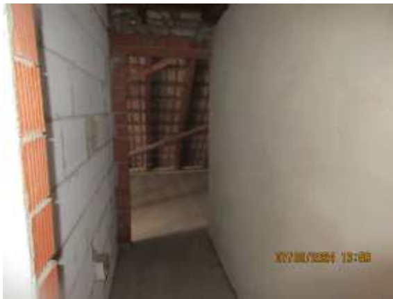
Mauer / Wand parallel zur südlichen Treppenhauswand
