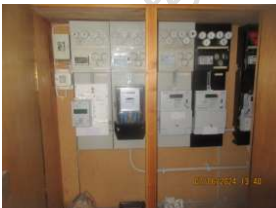
Zähler- / Sicherungskasten
