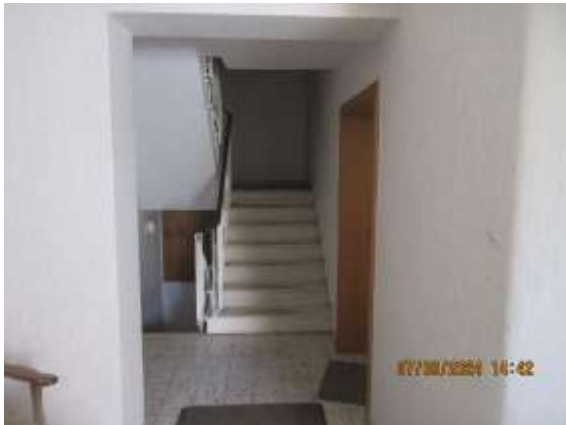
Treppe zum OG
