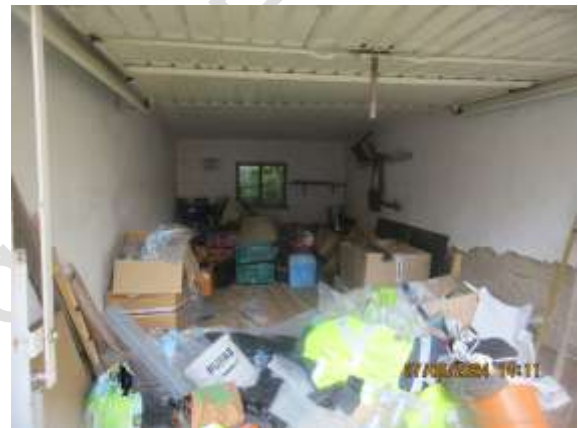
Blick in die Garage im Westen
