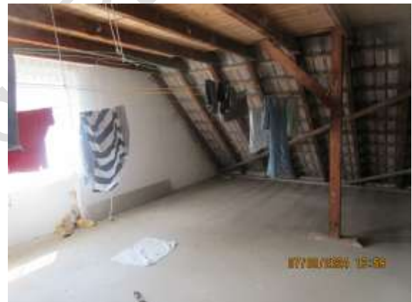
Bodenraum zur Straße
