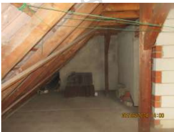
Bodenraum im Westen
