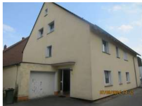
Ansicht von Nordwesten / Haupteingang
