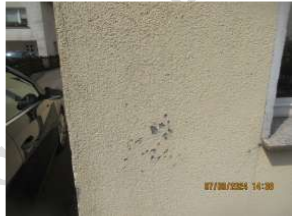
Putzschaden / Südfassade
