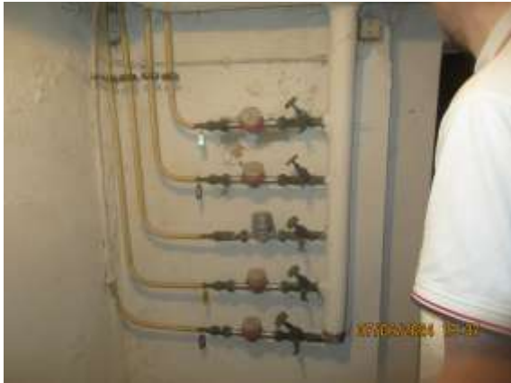
Wassermähler / Warmwasser
