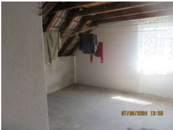
Bodenraum zur Straße
