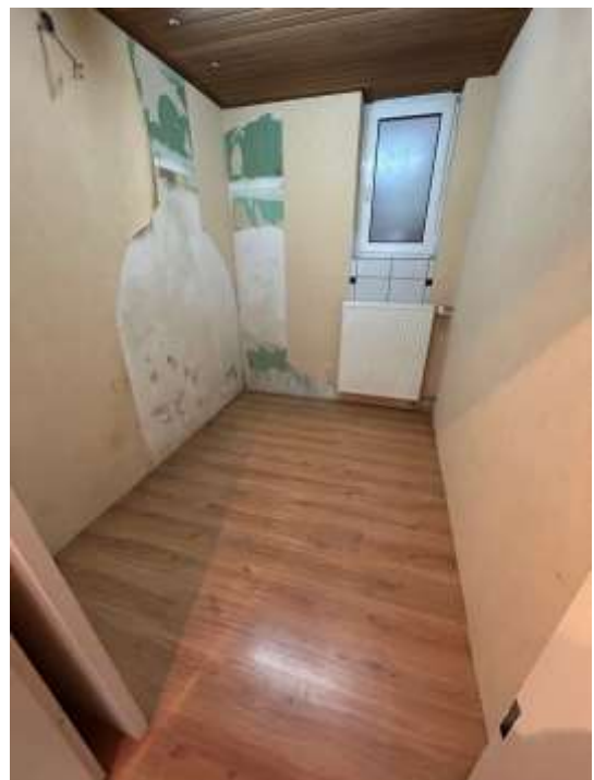
Bild: 18 / 20 Souterain-AR mit Schimmelbildung im Wandbereich
