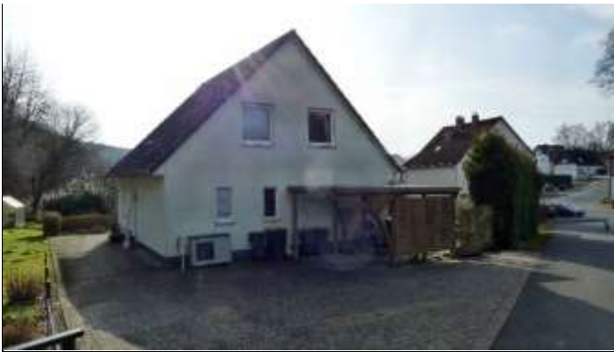
-1- Straßenansicht von Nordwesten
