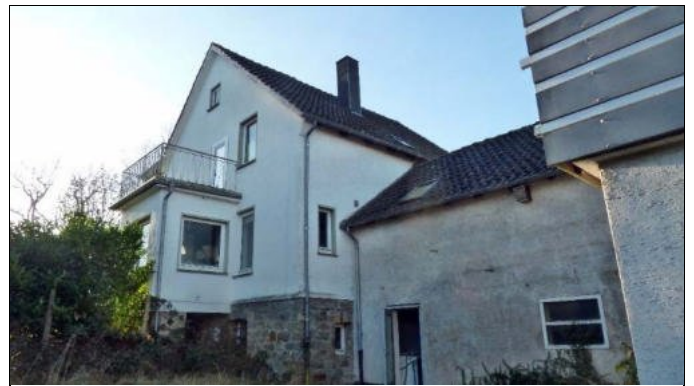
-4- Teilansicht Wohnhaus, Anbau
