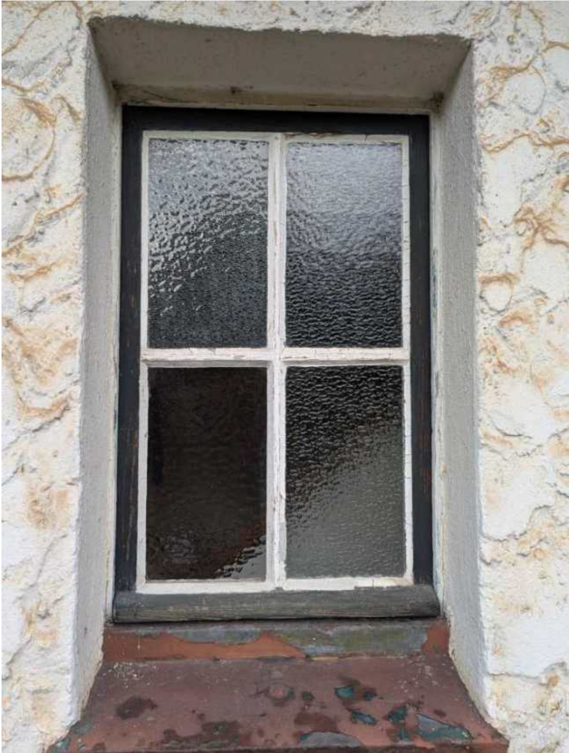
Lfd. Nr. 1 Wohnhaus Holzfenster
