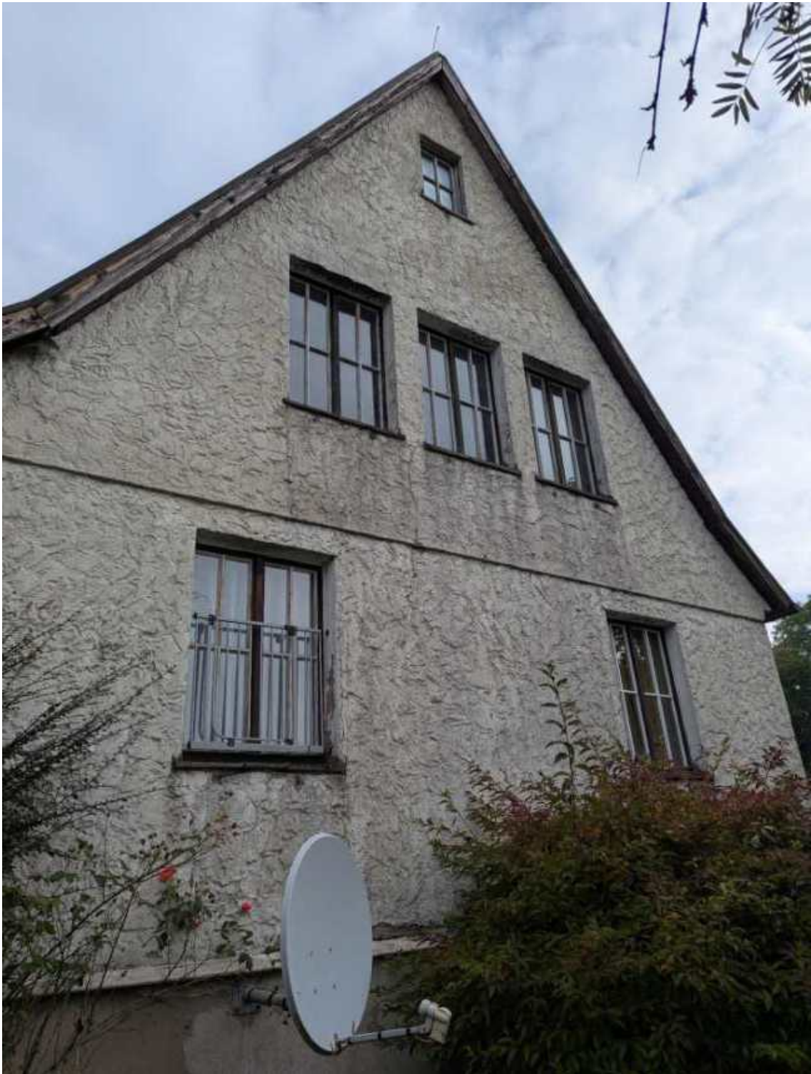
Lfd. Nr. 1 Wohnhaus Seitenansicht
