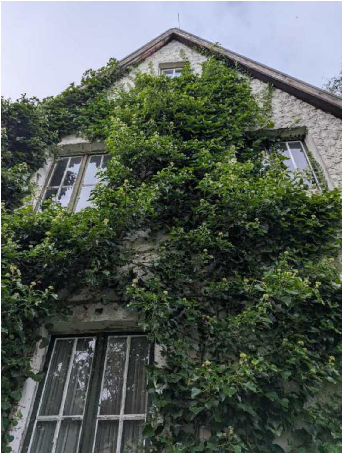
Lfd. Nr. 1 Wohnhaus Seitenansicht
