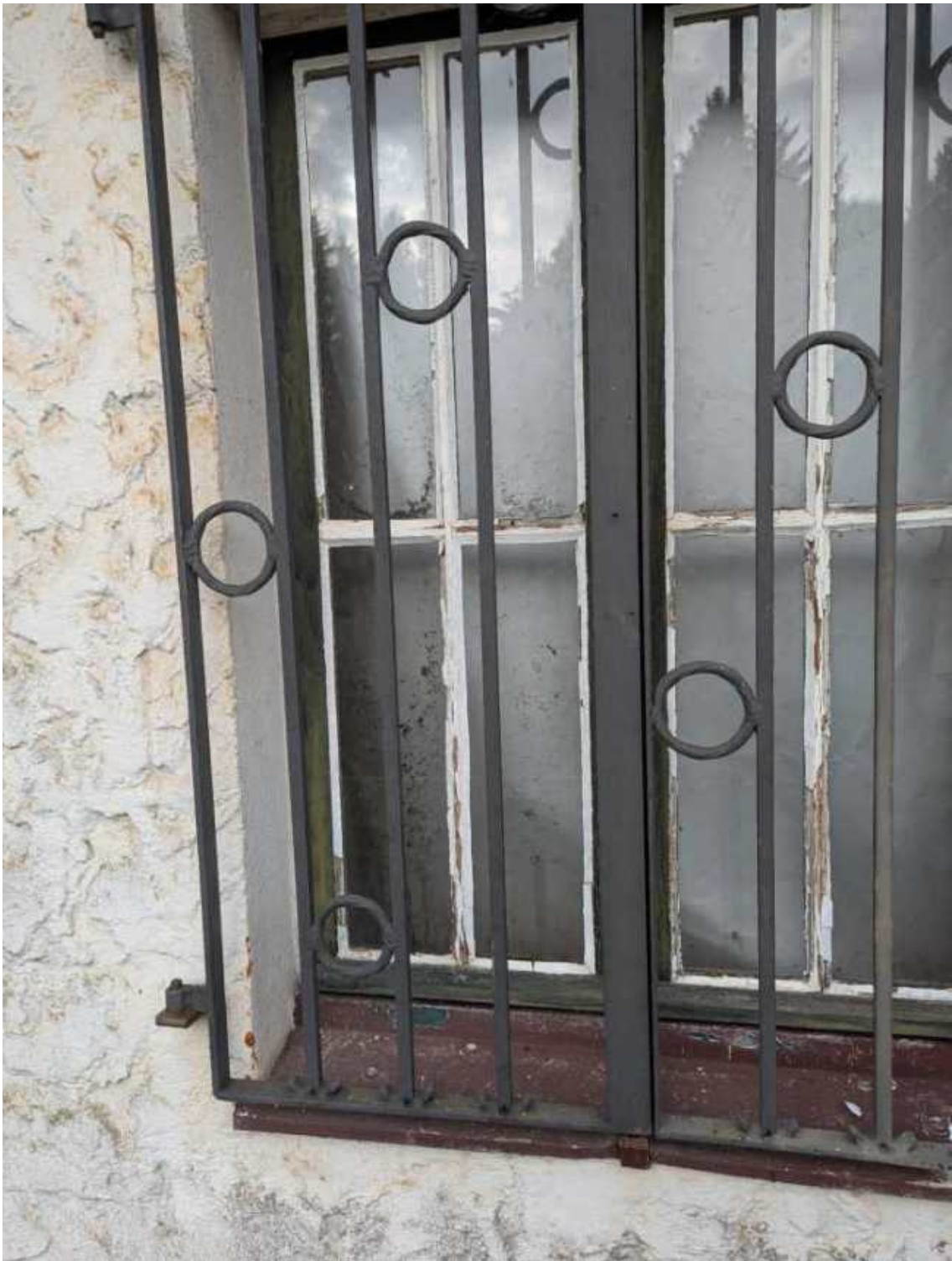
Lfd. Nr. 1 Wohnhaus Holzfenster
