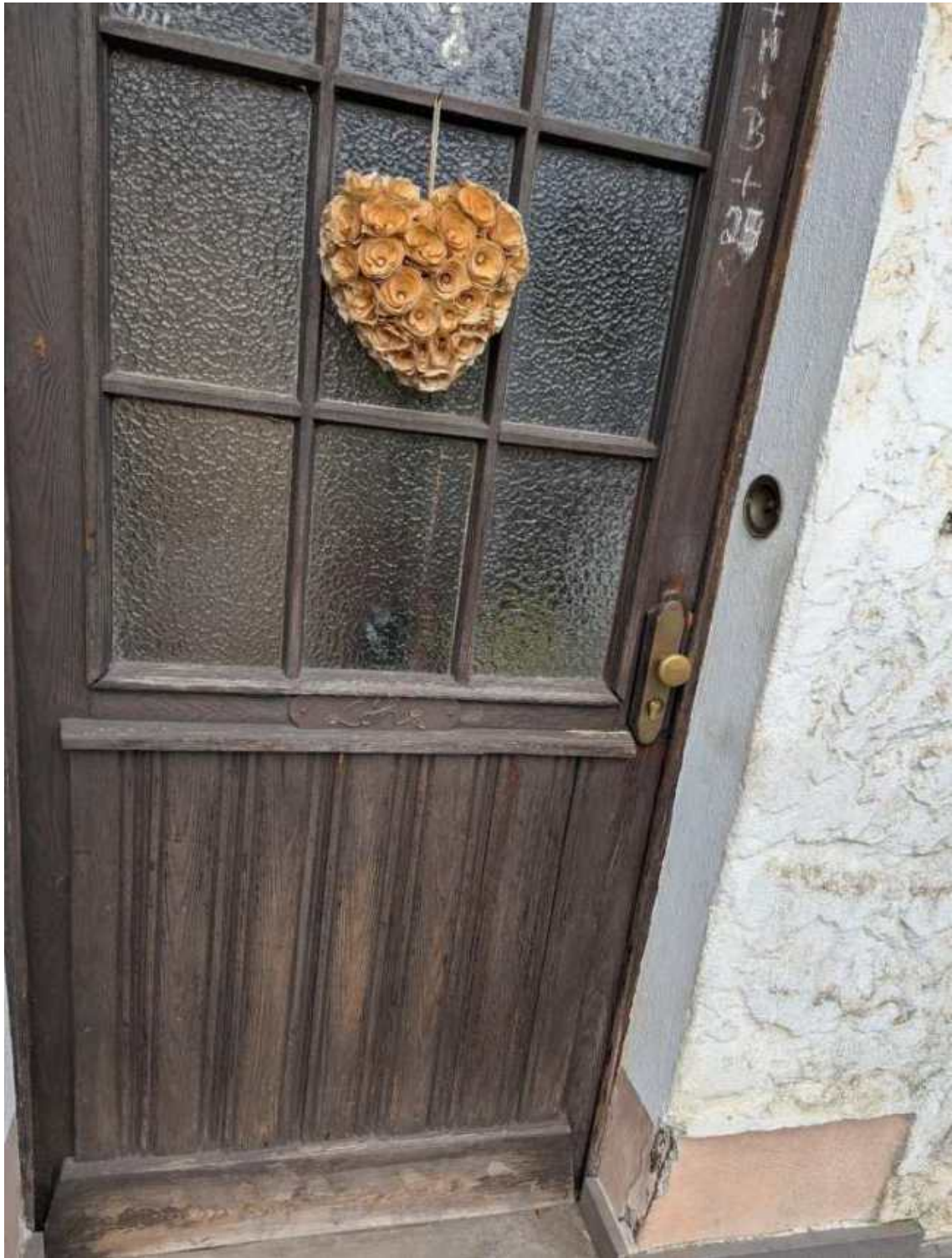
Lfd. Nr. 1 Wohnhaus Eingangstür
