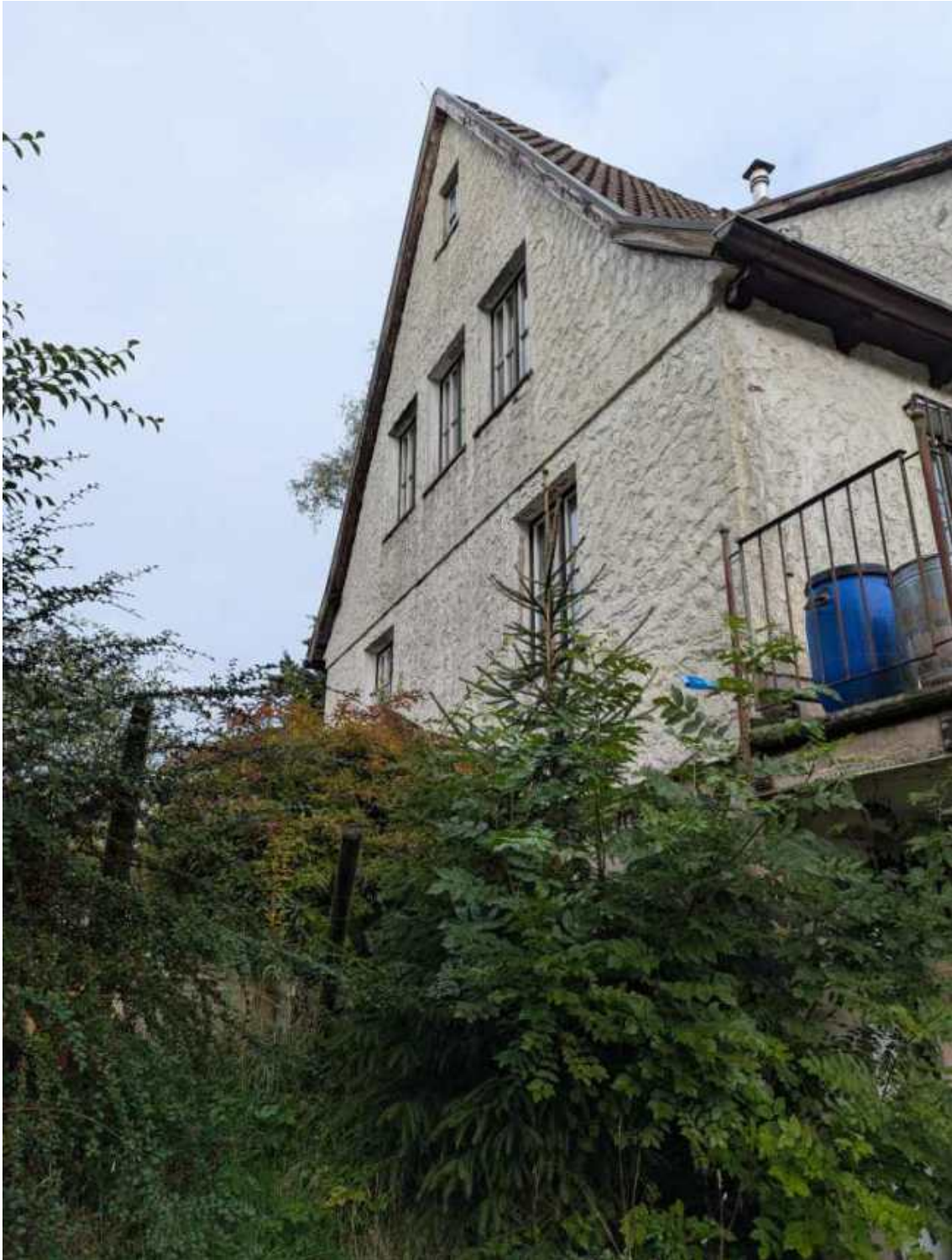
Lfd. Nr. 1 Wohnhaus Seitenansicht
