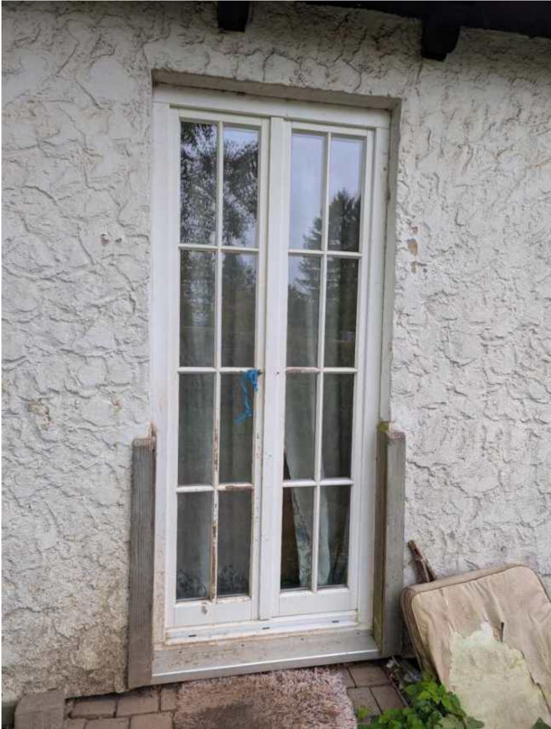
Lfd. Nr. 1 Wohnhaus bodentiefes Holzfenster
