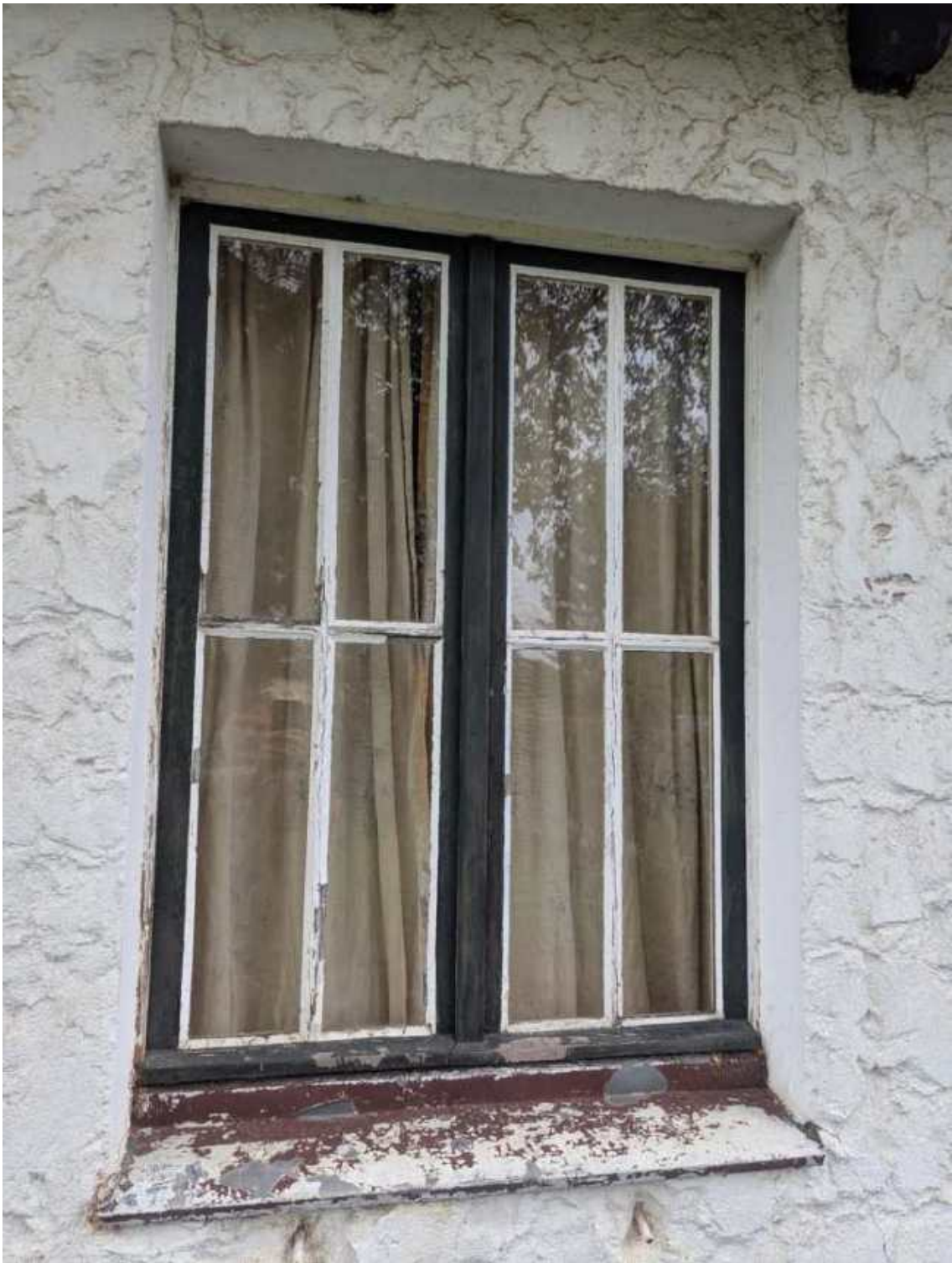
Lfd. Nr. 1 Wohnhaus Holzfenster
