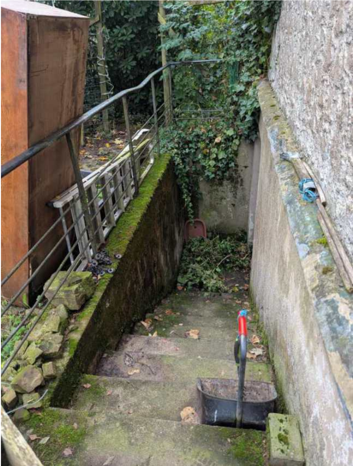
Lfd. Nr. 1 Wohnhaus Kelleraußentreppe
