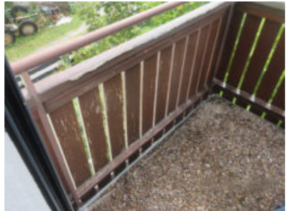
Balkon / Geländer Anstrichschäden/ fehlender Belag
