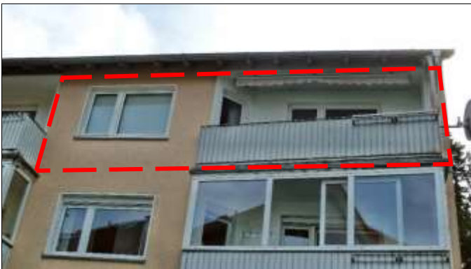
-6- Detailansicht WE 12 Westseite
