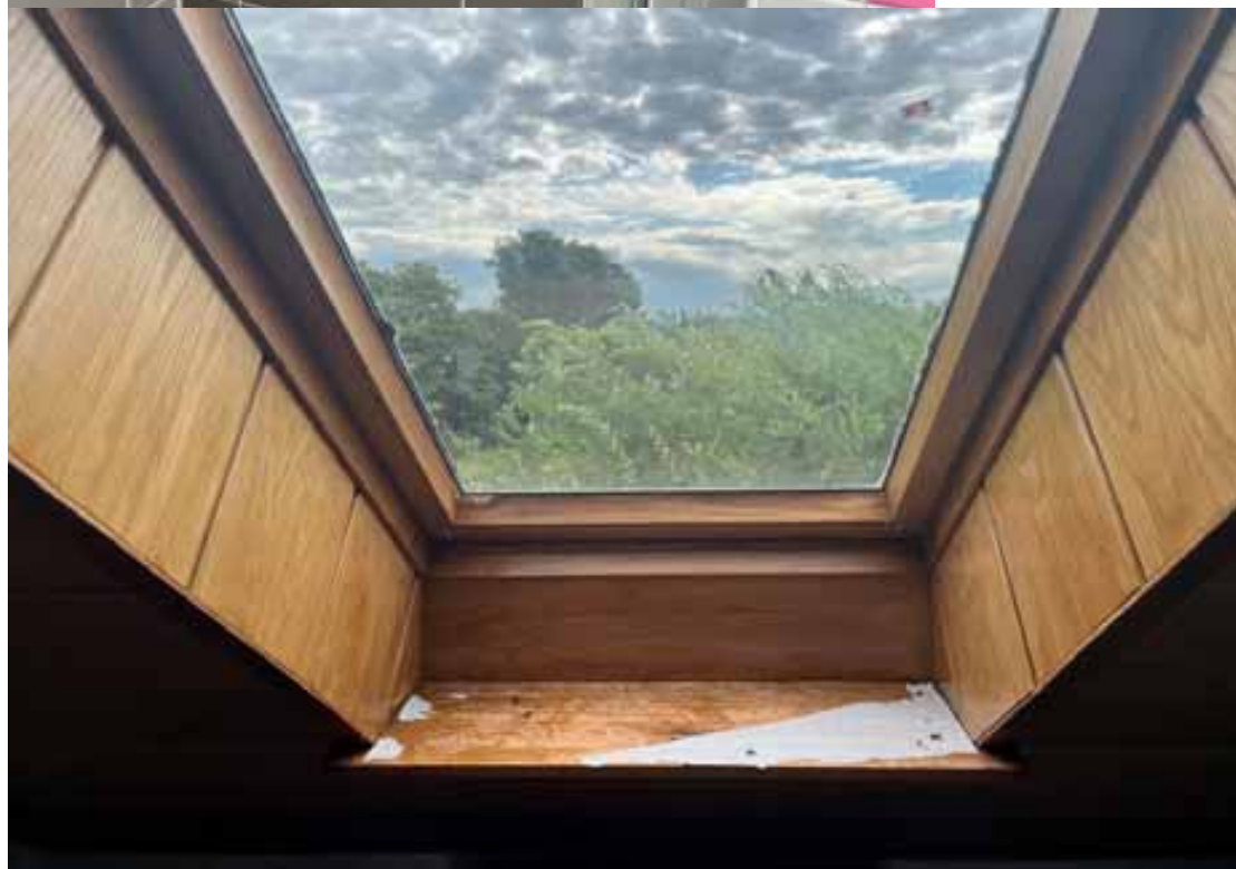
Defektes Dachfenster
