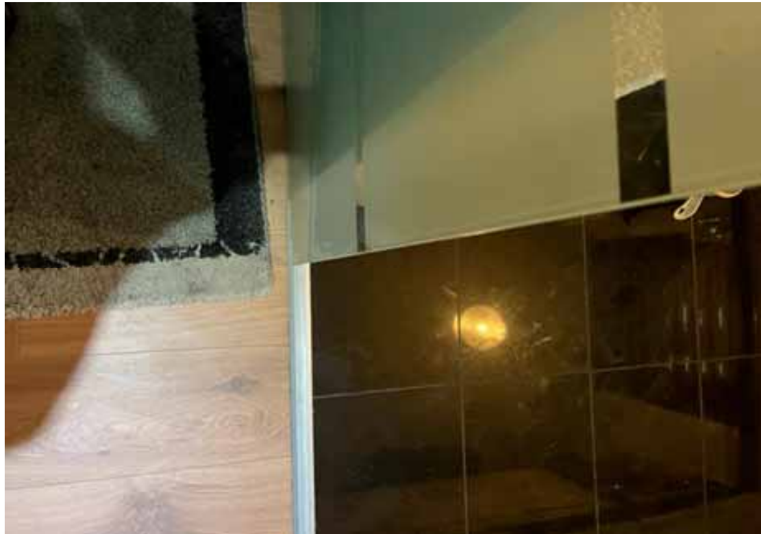
Sanierter Bodenbelag - sanierte Innentür im Sondereigentum
