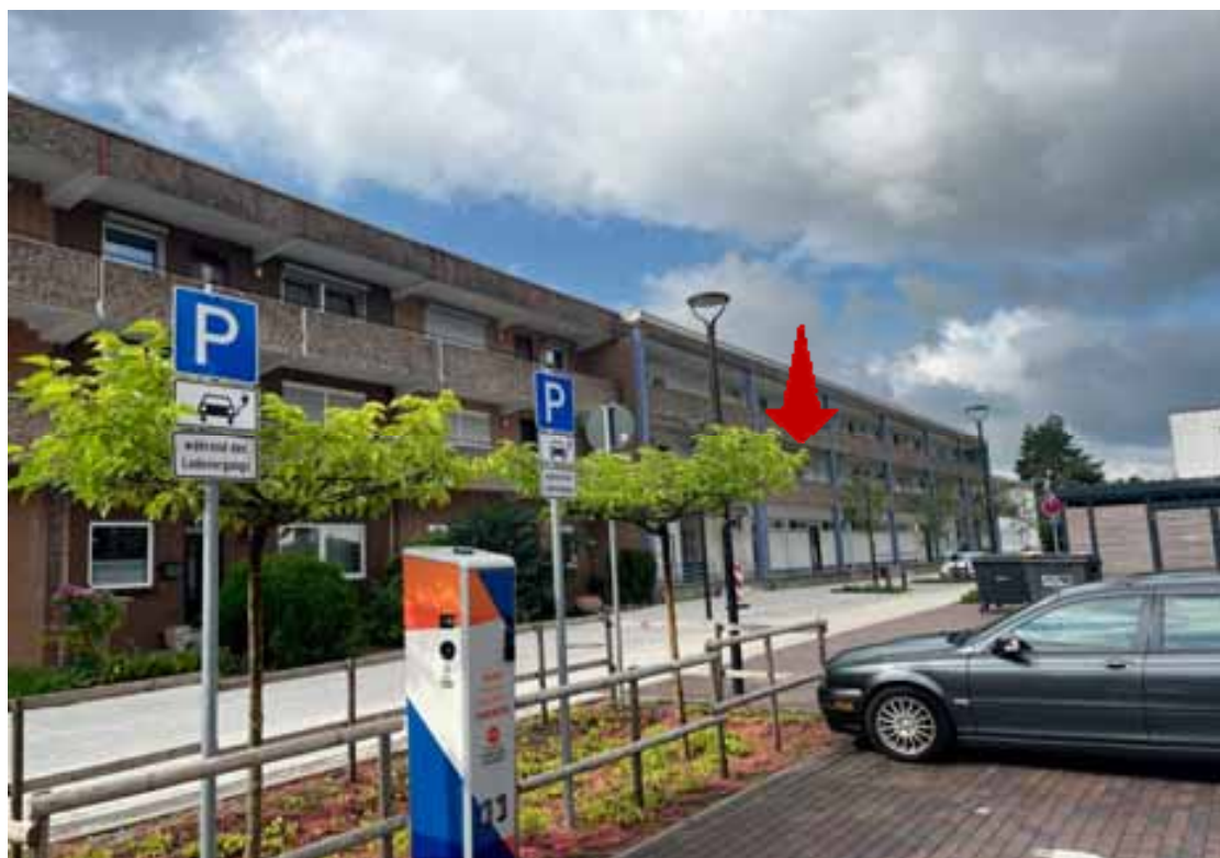
Innenhof und Ansicht vom Schulparkplatz aus
