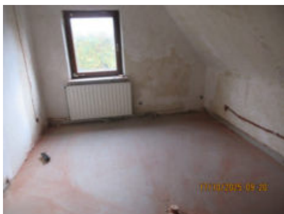
Vorbereitung der Elektroinstallation im DG
