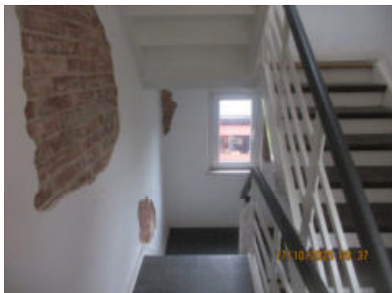
Oberflächen-/ Putzgestaltung im Treppenhaus
