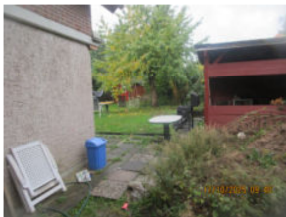
Links – Außenwand des Anbaus/ Blick in den Garten
