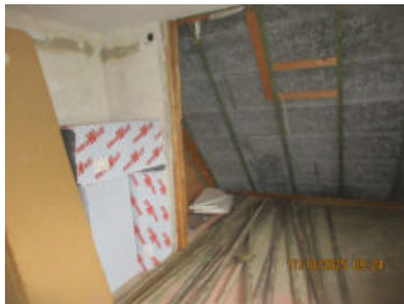
Dachdämmung im DG
