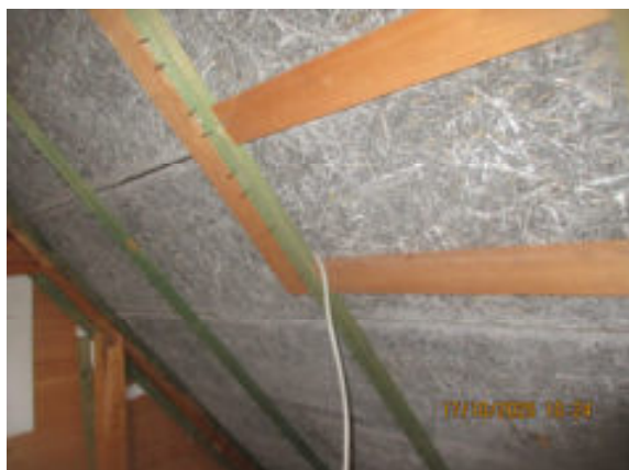
Dachdämmung im DG
