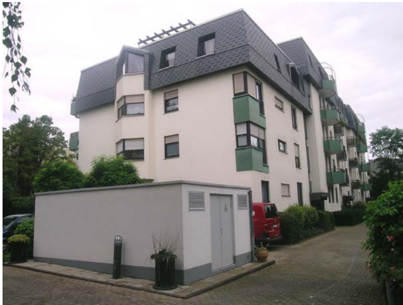
Giebel mit Trafo
