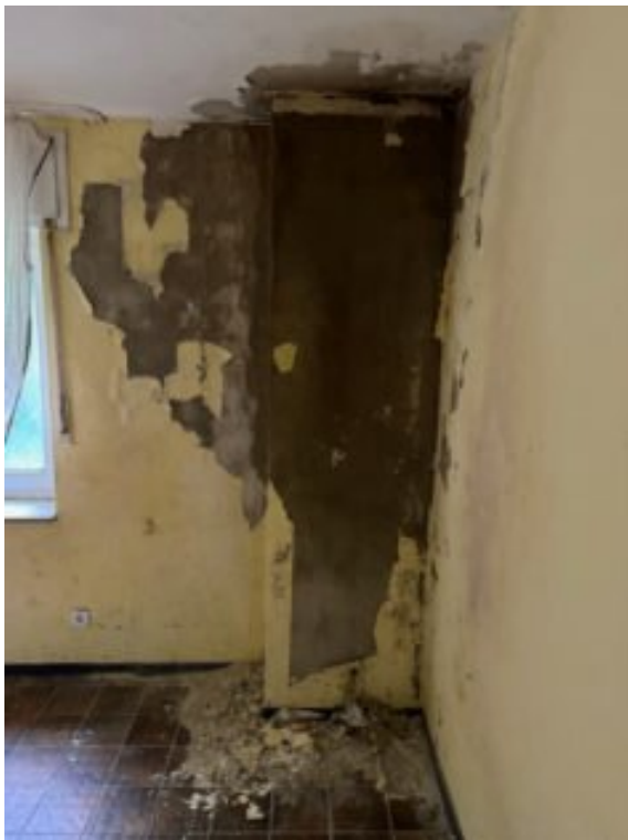
Feuchteinwirkung am Schornstein etc.
