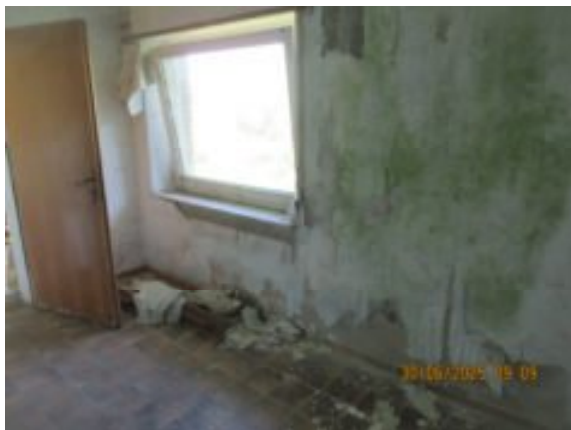
Feuchteeinwirkung mit Schimmelbildung Außenwand
