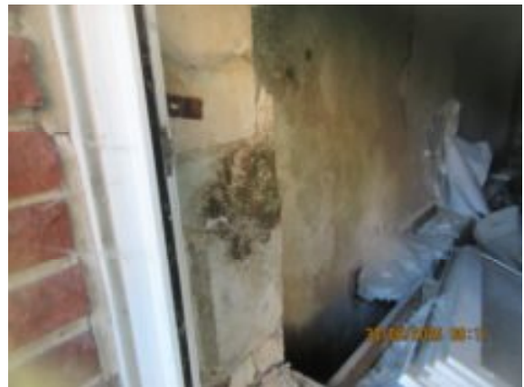
Fensterlaibung innen mit schadhaftem Putz
