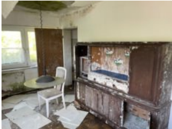
Undichtetes Flachdach / Großflächige Feuchteinwirkung
