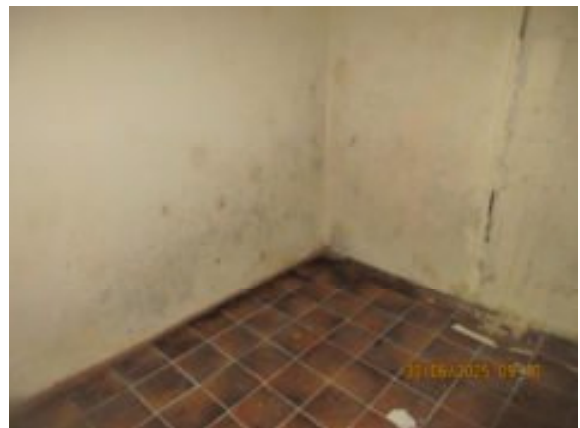
Küchenwand innen mit Feuchtespuren
