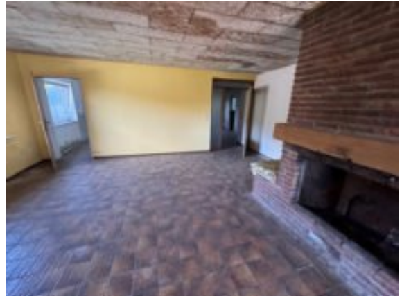
Deckenverkleidung / Belag durch Feuchte
