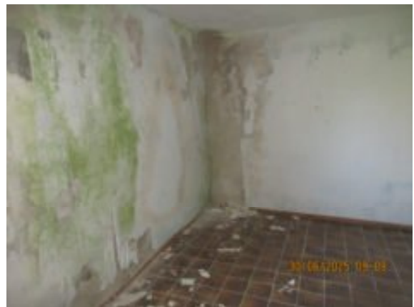
Feuchteeinwirkung in der Außenecke
