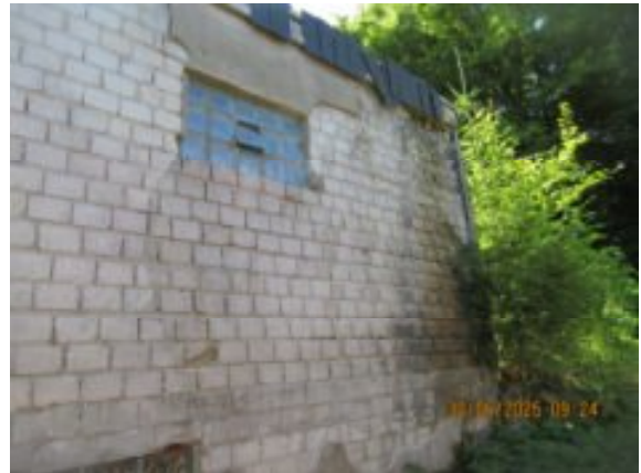
Außenwand im Westen / starke Feuchteinwirkungen / schadhafte Dachverkleidung
