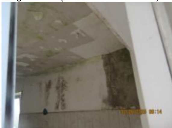
Küche mit Polystyrolplatten unter der Decke
