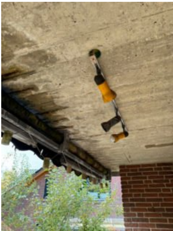
Feuchte am Dachüberstand mit sichtbaren rostenden Stahleinlagen
