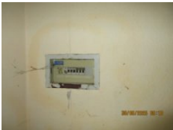
Stromverteiler mit Kippschaltern
