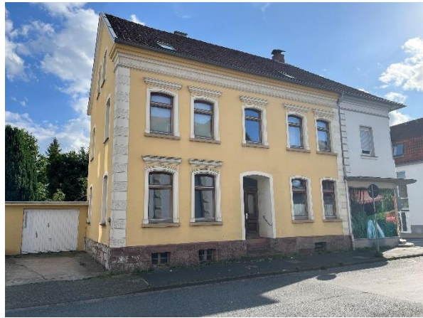
Nordfassade mit Zugang
