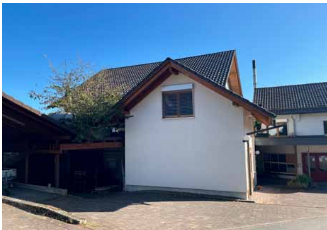
Wohn- und Geschäftshaus - links offene Garage erkennbar
