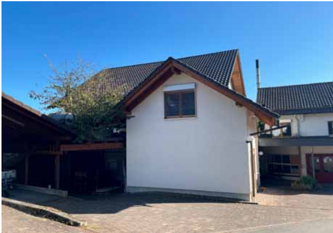
Wohn- und Geschäftshaus - links offene Garage erkennbar
