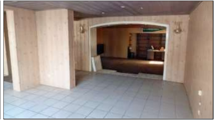
-11- straßenseitige Gewerbefläche EG rechts
