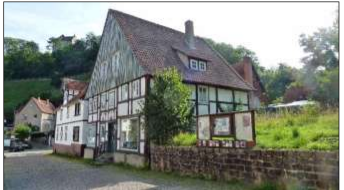
-2- Straßenansicht von Südwesten
