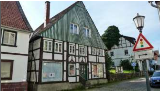
-1- Straßenansicht von Nordwesten
