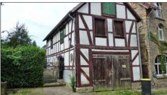
-16- Straßenansicht von Nordosten
