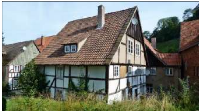
-4- Ansicht von Südost
