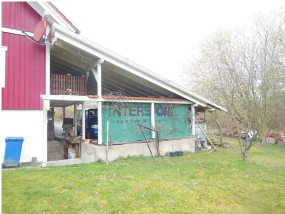
rückwärtige Ostansicht des Carports
