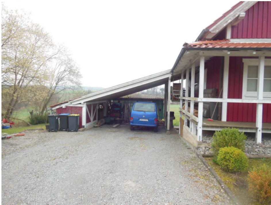
Zufahrt zum Carport und Veranda als überdachter Zugang
