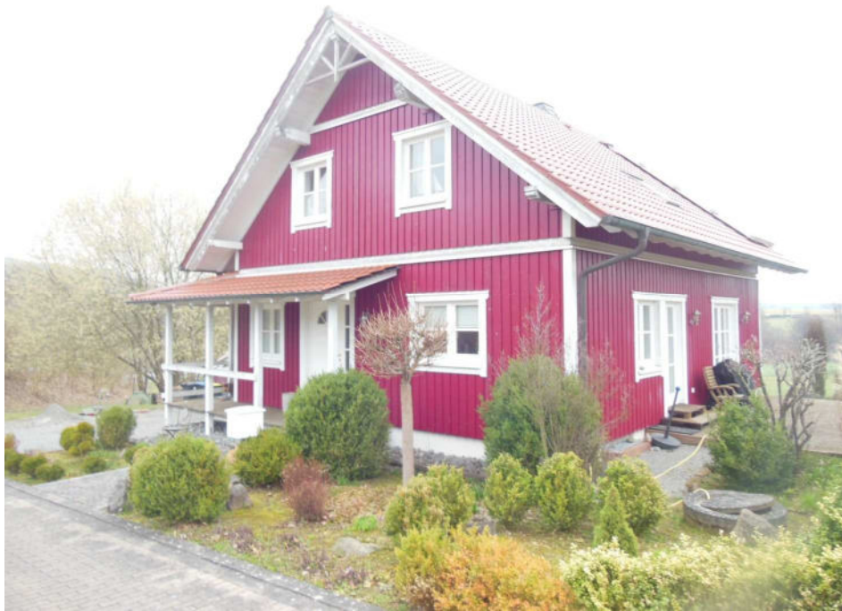
straßenseitige Westansicht mit dem Hauszugang und der Überdachung durch die Veranda
