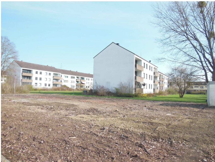
Nordgiebel und Westseite des Gebäudekomplexes
