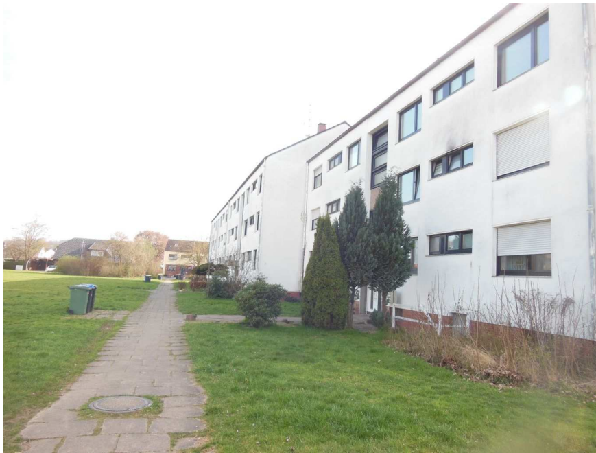
Ostseite des Gebäudekomplexes
